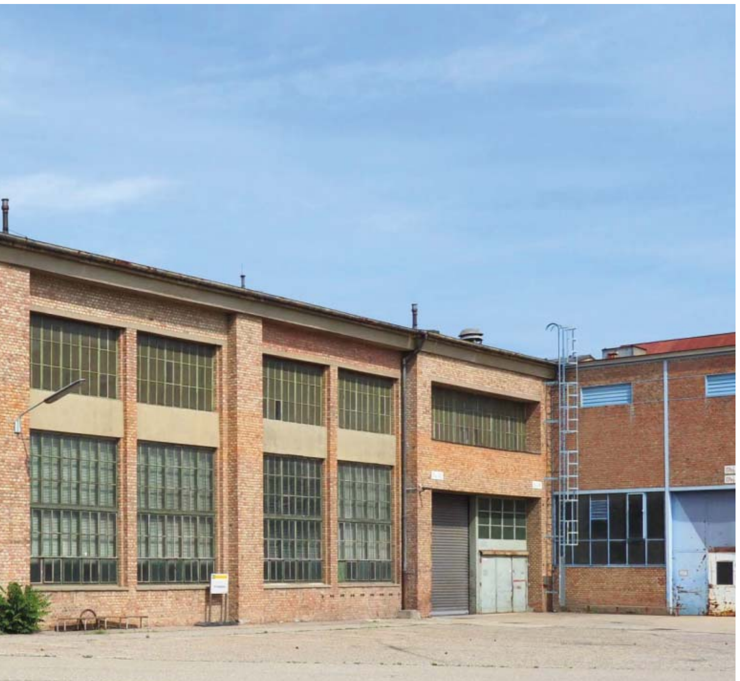
Abb. 1: Außenansicht der historischen Bereiche der Paukerwerke vor dem Beginn der Abbrucharbeiten, Blick auf die Erweiterungsbauten, welche an die große Haupthalle anschließen.
