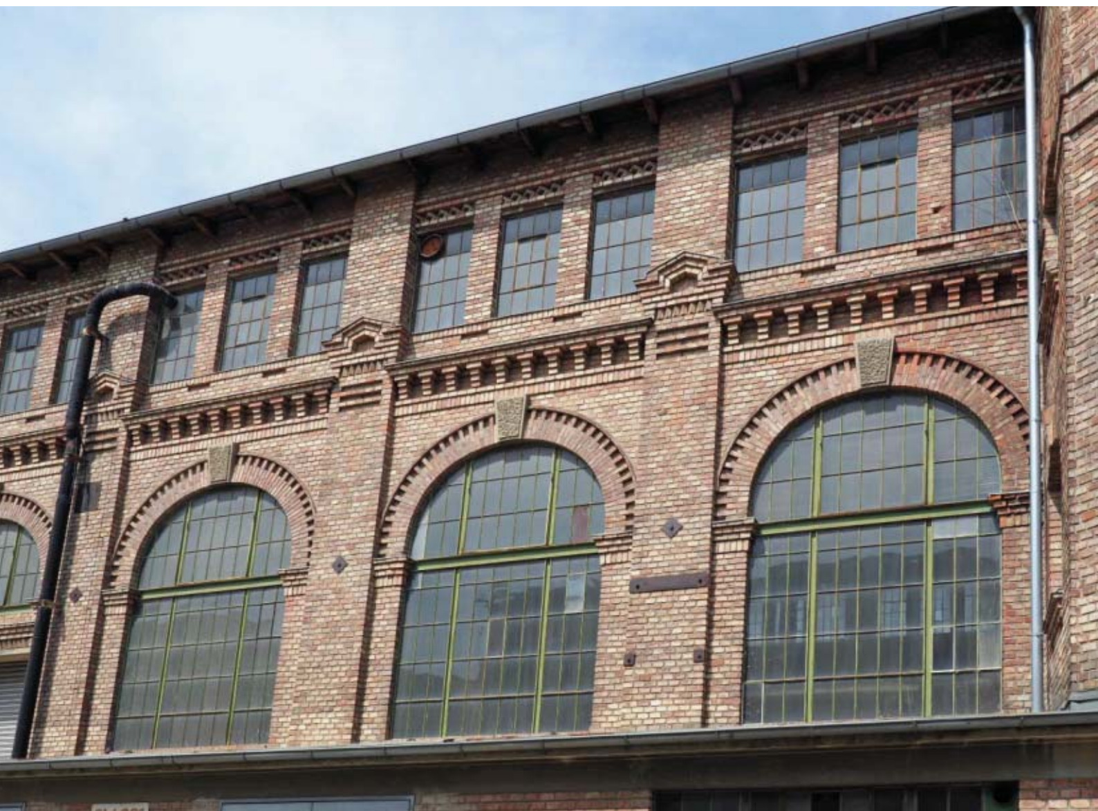
Abb. 2 (o.): Die eleganten Bogenfenster der Turbinenwerkstätte, Bauteil 230; vgl. auch mit dem Foto des Abbruchs (Abb. 7) auf Seite 12
