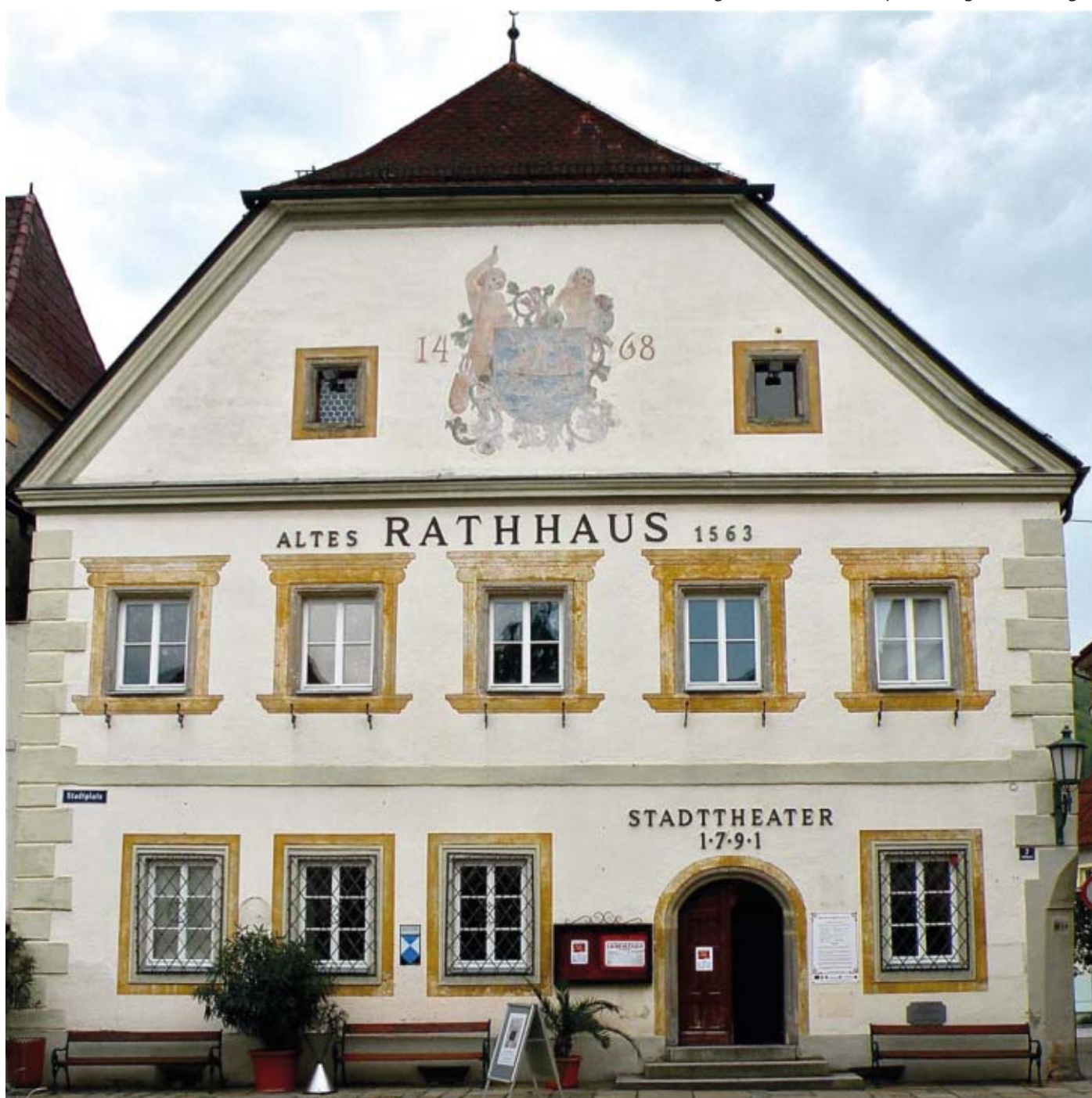
Abb. 27: Problematische Modernisierung des Stadt-Theaters in Grein, das derzeit als ältestes Bürgertheater Mitteleuropas im Originalzustand gilt.
