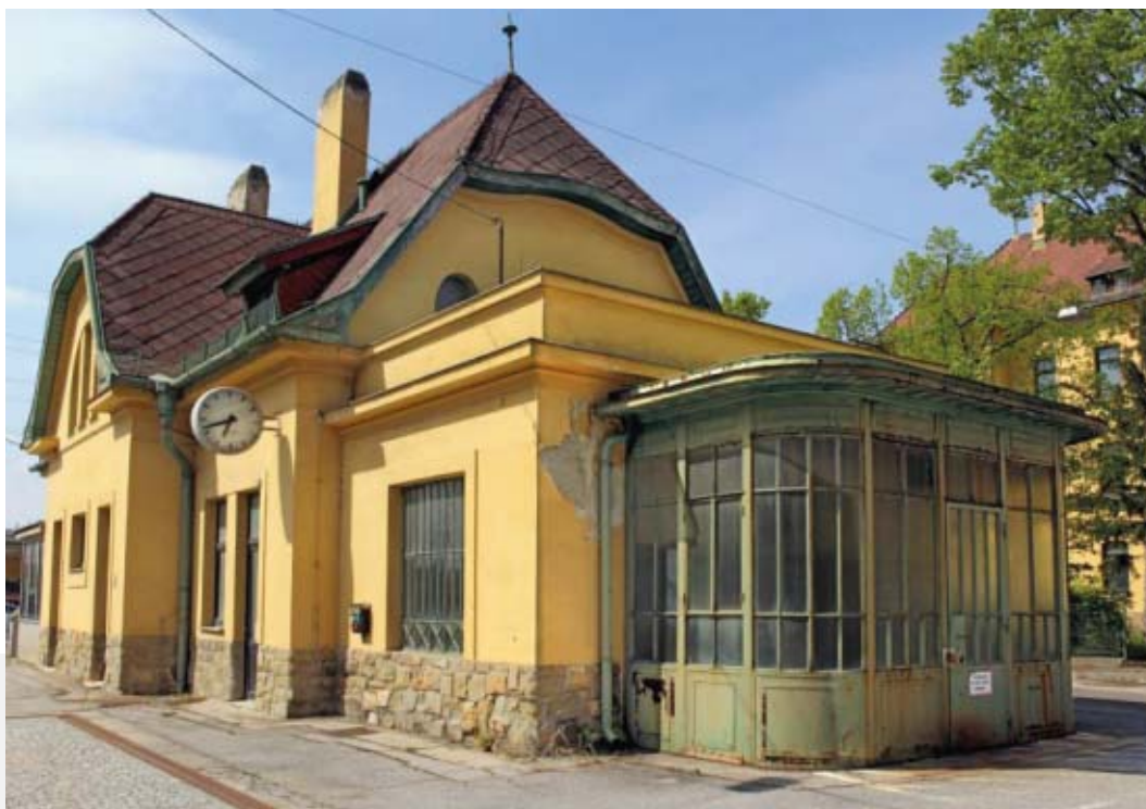
Abb. 56 (re.): Ein Foto vom April 2016 (anlässlich der erwähnten Führung) zeigt, dass sogar weniger relevante Bauteile wie dieses Eingangs- gebäude einst liebevoll und durchdacht gestaltet wurden.
