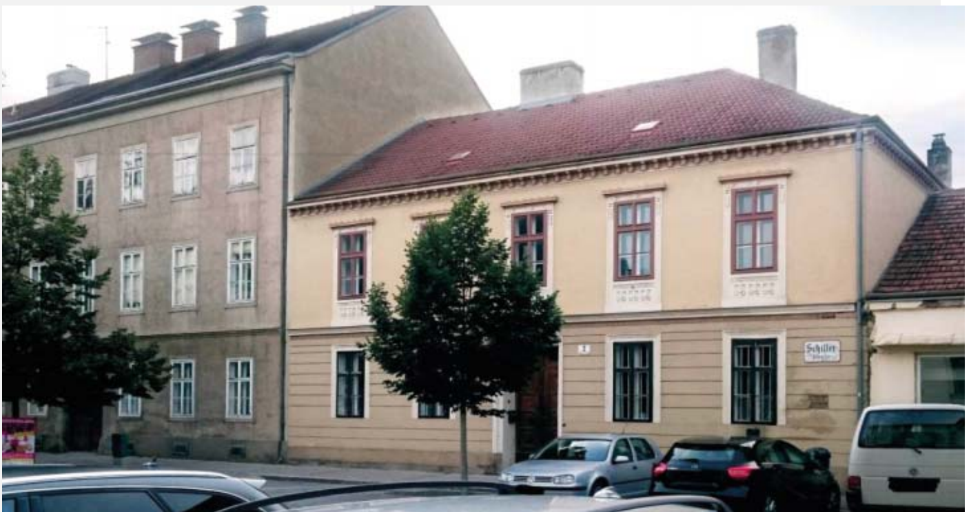
Abb. 24 (u.): Die Gebäude Schillerstraße 2-4 in Krems sind – entgegen einer 20 Jahre älteren Einschätzung – nun nicht mehr „denkmalwürdig“, ein trauriger Beleg für einen Paradigmen- wechsel bei den Bewertungsmaßstäben des Denkmalamtes.
