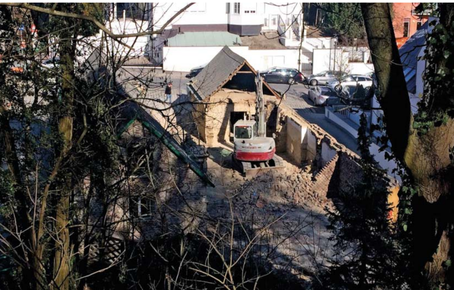
Abb. 32 (o.) Und 33 (u.): Teilabbruch des linken Traktes im Februar 2019.
