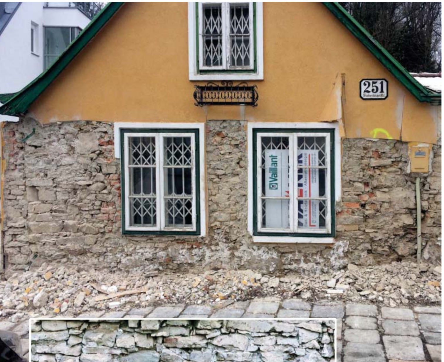
Abb. 29 (oben): Nach der Entfernung des Putzes wird Bruchsteinmauerwerk erkennbar, die Grundmauer stammt möglicherweise aus dem Spätmittelalter. Auch im Bereich des abgebrochenen Haustraktes waren solche Bruchsteinmauern sichtbar (Foto vom Dezember 2018)
