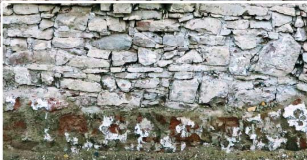
Abb. 29 (oben): Nach der Entfernung des Putzes wird Bruchsteinmauerwerk erkennbar, die Grundmauer stammt möglicherweise aus dem Spätmittelalter. Auch im Bereich des abgebrochenen Haustraktes waren solche Bruchsteinmauern sichtbar (Foto vom Dezember 2018)
