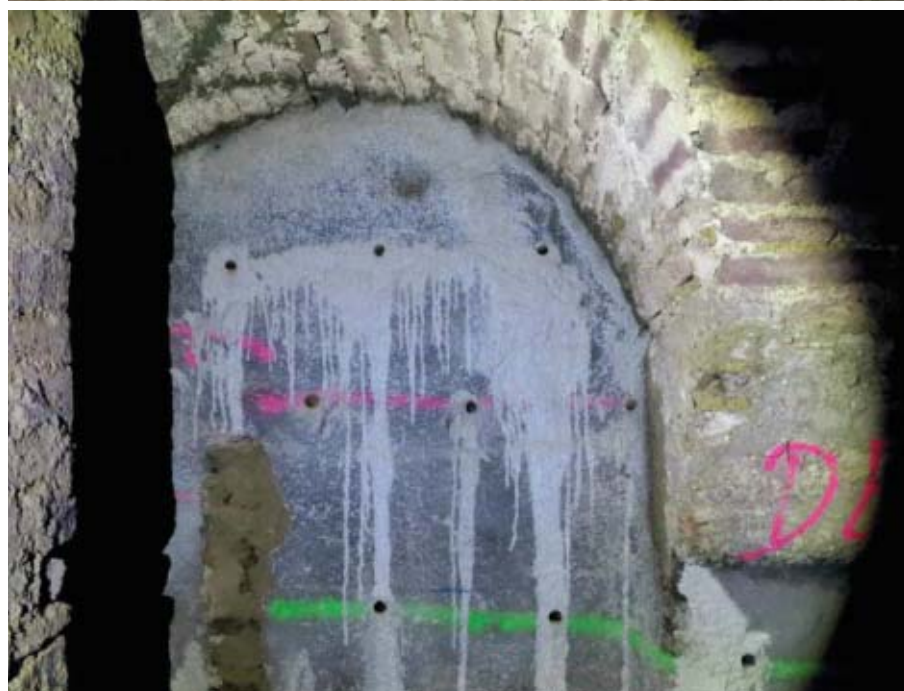
Abb. 17 (o.) und 18 (u.): Ziegelgewölbe mit Blick auf eine Jahrhunderte alte Steinmauer, oben noch unversehrt im Jahr 2014, darunter dieselbe Stelle mit Metallankern und Aufbringung von Spritzbetonbeschichtung
