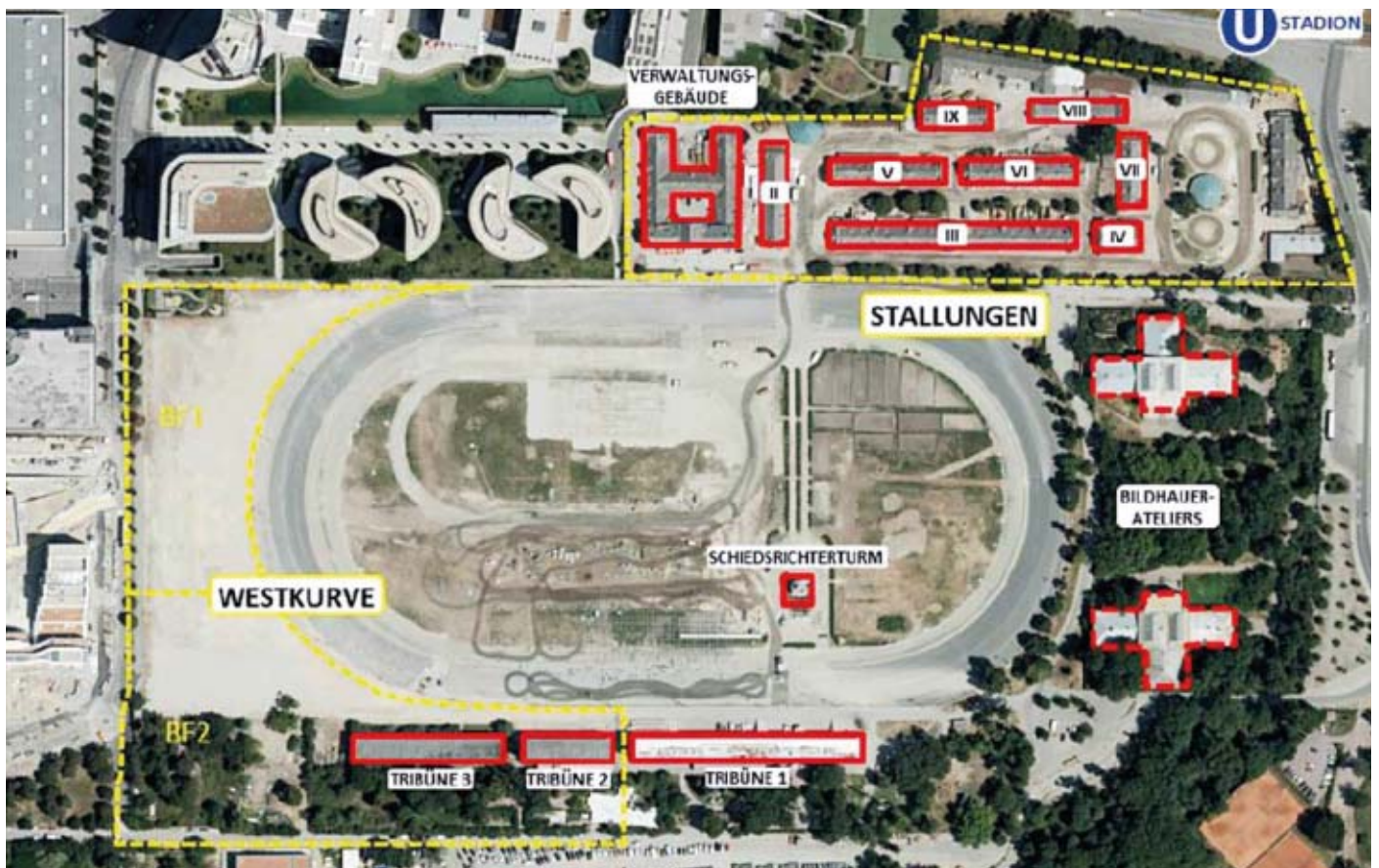
Abb. 3: Darstellung des „Ist-Zustandes“ im Jahr 2014 aus den Presseunterlagen der Pressekonferenz am 26.2.2014. Rot eingerahmt die denkmalgeschützten Stallungen (rechts oben), Tribünen (unten) und zwei Gebäude, die noch von der Weltausstellung 1873 stammen und heute als Bildhauerateliers dienen (rechts). Im Bereich der Westkurve wurde die Bahn im Jahr 2012 verkürzt, um Platz für lukrative Hochbauten zu schaffen (Baufeld 1 und 2). Unterhalb der Tribünen 2 u. 3 wurde inzwischen der Baumbestand gerodet, um das angrenzende Areal ebenfalls zu verbauen (siehe Bild 13).
