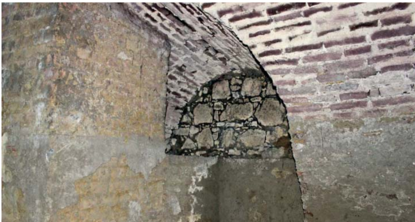
Abb. 17 (o.) und 18 (u.): Ziegelgewölbe mit Blick auf eine Jahrhunderte alte Steinmauer, oben noch unversehrt im Jahr 2014, darunter dieselbe Stelle mit Metallankern und Aufbringung von Spritzbetonbeschichtung
