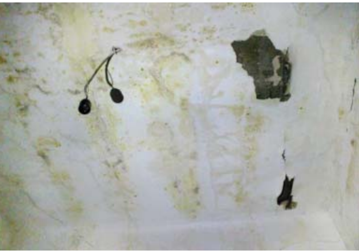
▲ Abb. 39 (li. oben), Abb. 40 (oben) und Abb. 41 (oben rechts): Wasserschäden und Schimmel verursacht durch das im Sommer 2018 entfernte Dach (Fotos Herbst 2018), die Wohnung in Abb. 41 wurde damals noch bewohnt; Abb. 39 und 40 zeigen die Räume oberhalb (!) der Abdichtfolie. ◀ Abb. 42 (li. unten): Kunstvolle holzgeschnitzte Türeinfassung in einer Wohnung im obersten Stockwerk nach der Entfernung von Dach und Dachboden. Unten eine schwarze Folie, die notdürftig das Regenwasser am Eindringen in die bewohnten Wohnungen hindern soll (beim gerichtlichen Lokalaußenschein am 12.12.2018); ▼ Abb. 43 (unten): Am 1. Juli 2018 hat der Hauseigentümer bereits die Fenster jener Wohnungen entfernen lassen, die nicht bewohnt sind. Auch das Dach wird gerade demontiert. Daneben ein mustergültig erhaltenes Wohnhaus mit Schauffassade zum Donaukanal.
