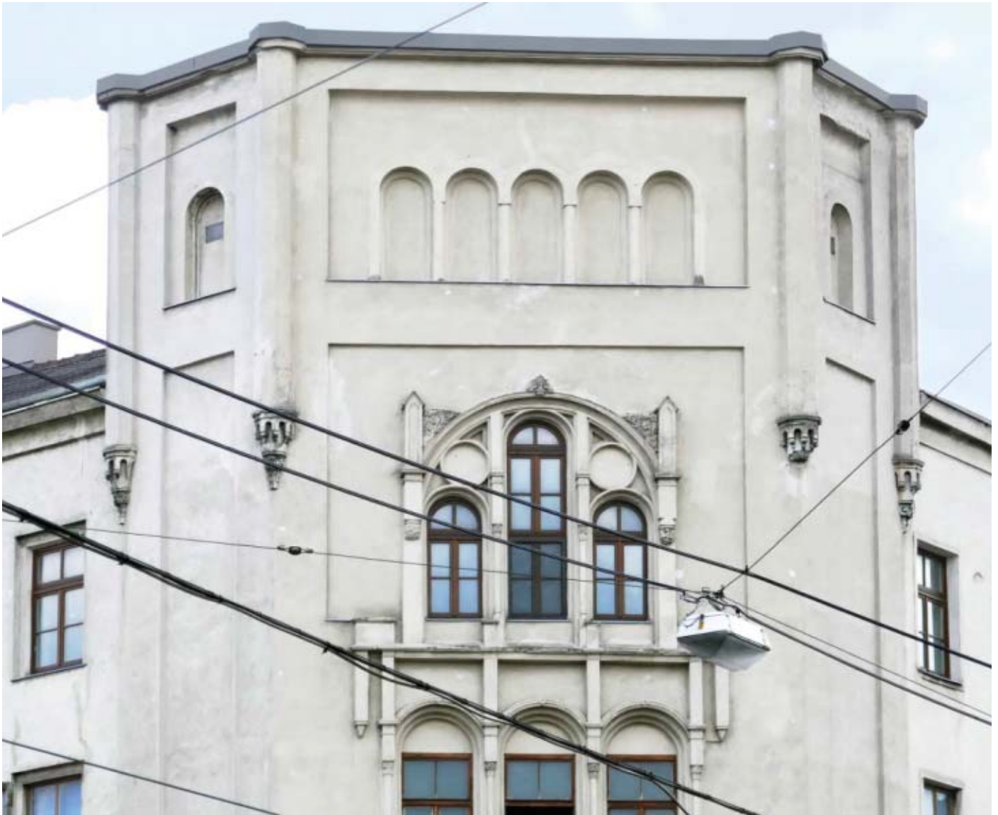
Abb. 36 (linke Seite) und 37 (o.): Der im Mai 2018 (also wenige Wochen vor Inkrafttreten der Bauordnungsnovelle am 30.6.2018) noch komplett erhaltene imposante Eckaufbau mit romanisch inspirierten Bogenformen stammte wie das gesamte Bauwerk aus dem Jahr 1847. Fotos © Erich J. Schimek
