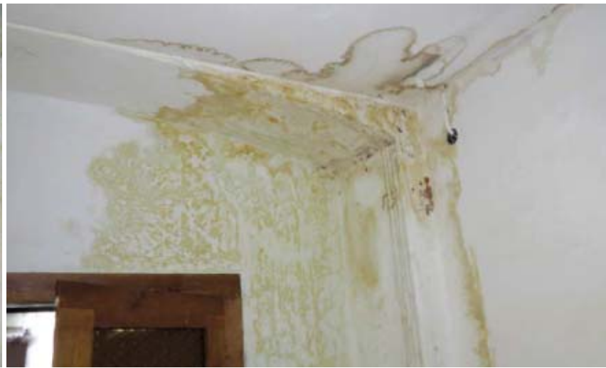
▲ Abb. 39 (li. oben), Abb. 40 (oben) und Abb. 41 (oben rechts): Wasserschäden und Schimmel verursacht durch das im Sommer 2018 entfernte Dach (Fotos Herbst 2018), die Wohnung in Abb. 41 wurde damals noch bewohnt; Abb. 39 und 40 zeigen die Räume oberhalb (!) der Abdichtfolie. ◀ Abb. 42 (li. unten): Kunstvolle holzgeschnitzte Türeinfassung in einer Wohnung im obersten Stockwerk nach der Entfernung von Dach und Dachboden. Unten eine schwarze Folie, die notdürftig das Regenwasser am Eindringen in die bewohnten Wohnungen hindern soll (beim gerichtlichen Lokalaußenschein am 12.12.2018); ▼ Abb. 43 (unten): Am 1. Juli 2018 hat der Hauseigentümer bereits die Fenster jener Wohnungen entfernen lassen, die nicht bewohnt sind. Auch das Dach wird gerade demontiert. Daneben ein mustergültig erhaltenes Wohnhaus mit Schauffassade zum Donaukanal.
