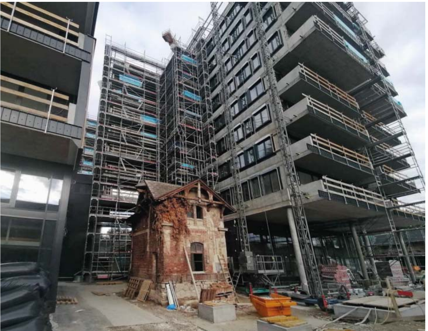
Abb. 13 (oben): Blick auf die Rückseite der Tribüne 3 (links). Rechts im Bild der ehemals bewaldete Bereich, der dem Wald Richtung Prater-Hauptallee zugewandt ist und nun als profitables Bauland genutzt wird. Abb. 14 (unten): Der nordwestliche Rest vom denkmalgeschützten Stall VIII im Oktober 2020, bereits umgeben von Hochhausrohbauten mit künftigen „Premiumwohnungen“; vgl. auch Titelbild auf Seite 1. Im Eck rechts unten ist bei genauem Hinsehen, hinter der zweiten orangenen Mulde, der südöstliche Eckbau von Stall VIII erkennbar.
