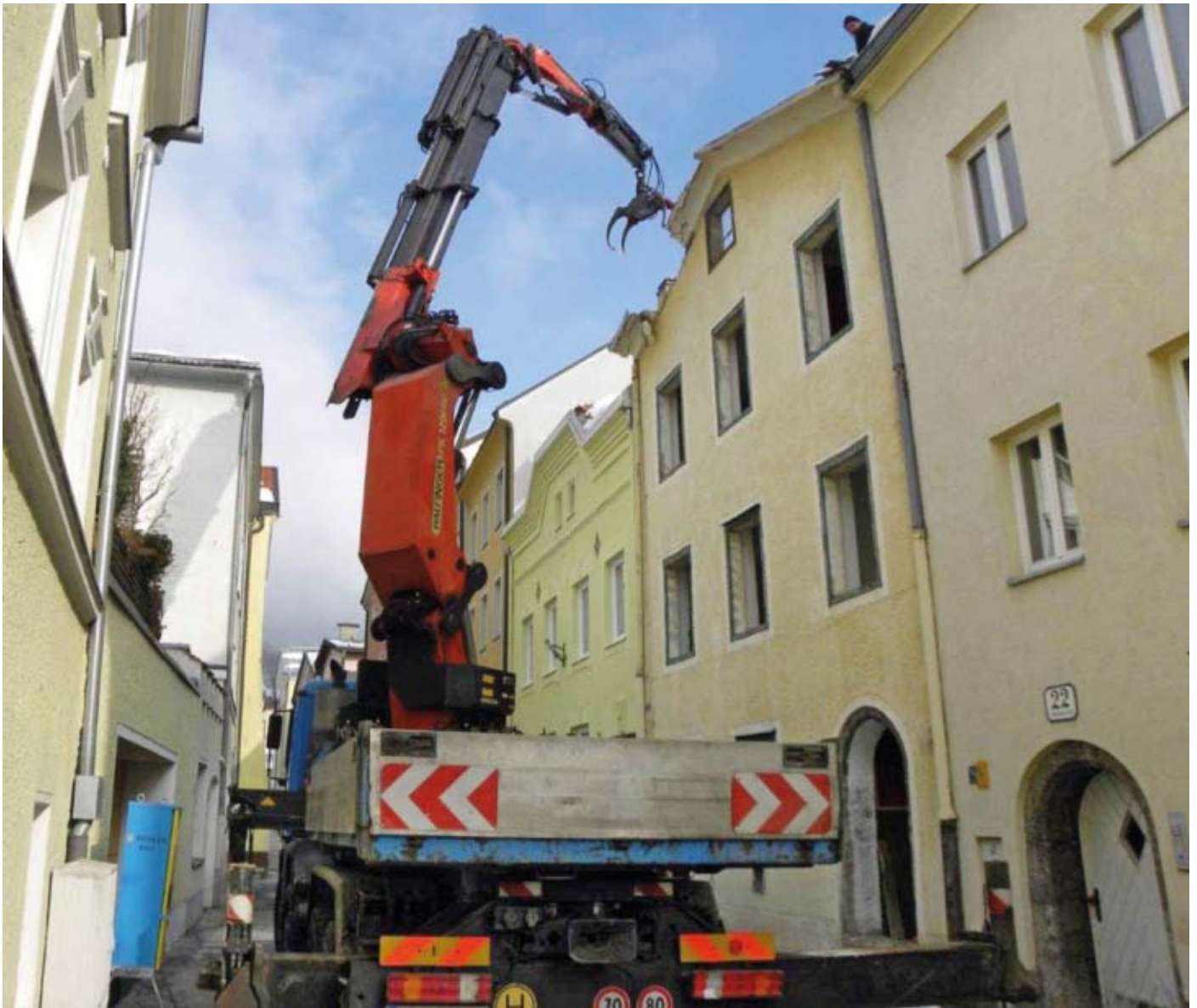
Abb. 44: Abriss des historischen Bauwerks St. Nikolaus-Gasse 24, dessen Bausubstanz aus dem 16./17. Jh. stammt. (2012 © Karlheinz Buemberger)
