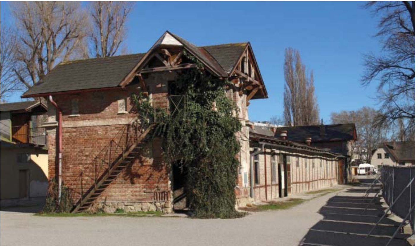
Abb. 4 (linke Seite, oben): Stall VII im Jahr 2018, inzwischen abgebrochen; Abb. 5 (linke Seite, unten): Das malerische denkmalgeschützte Stallgebäude IV im Fachwerkstil auf einem Foto von 2018. Es ist weder ein schlechter Bauzustand, noch eine „geringwertige Architekturqualität“ erkennbar. Das Bauwerk wurde abgerissen, obwohl an dieser Stelle offenbar kein Hochhaus geplant ist, sondern nur der Vorplatz zu den beiden Hochhäusern „Grünblick“ (90 Meter) und „Weitblick“ (120 Meter), deren Bau ab 2021 stattfinden soll; Abb. 6 (oben): Der denkmalgeschützte Stall VIII im April 2018, bereits verlassen, aber noch unversehrt. Abb. 7 (unten): Der denkmalgeschützte Stall VIII im April 2018. Zwischen den beiden markanten Eckbauten erstreckt sich der lange, im Fachwerkstil gestaltete Mittelteil.
