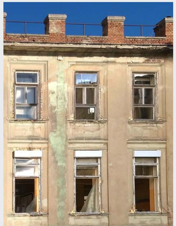
Abb. 2 (oben) und Abb. 2a (Detail unten Mitte): 2013 noch mit intakten Fenstern (Abb. 3, unten links), hat sich der Zustand inzwischen dramatisch verschlechtert. Durch „Anti-Terror-Übungen“ und andere devastierende Maßnahmen sind inzwischen dutzende Fenster zerstört und bestenfalls durch Plastikfolien abgedeckt oder stehen wie auf Abb. 4 (Bild unten rechts) ganz offen, und Wind und Regen können ungehindert eindringen.
