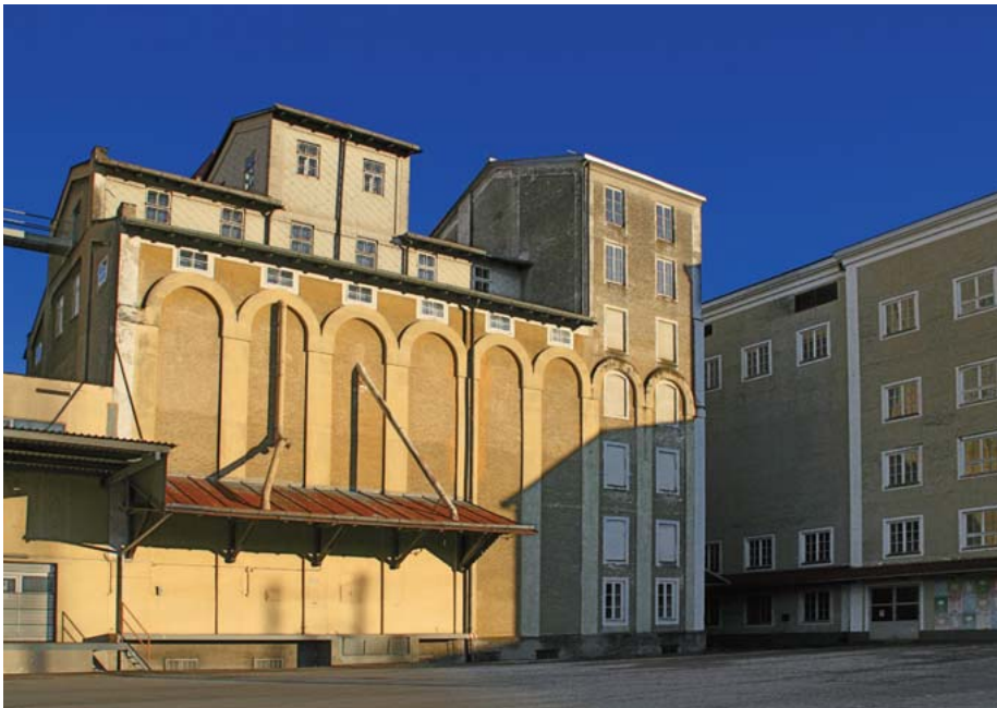
Abb. 55 (o.): Das gründerzeitliche Ensemble Fisslthaler Mühle mit Frachtenbahnhof, aber noch ohne Gleisanschluss, ca. 1912, zu sehen im Schaukasten in der Villa; Abb. 56 (u.): Die Westfassade des historischen Silos mit seinen Blendbögen. Zustand 2014.
