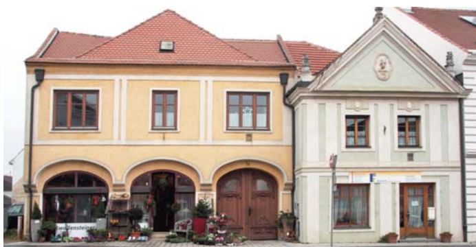
Abb. 89: NÖ - Herzogenburg, Kremser Straße 14 (re.) u. 16 (li.)
