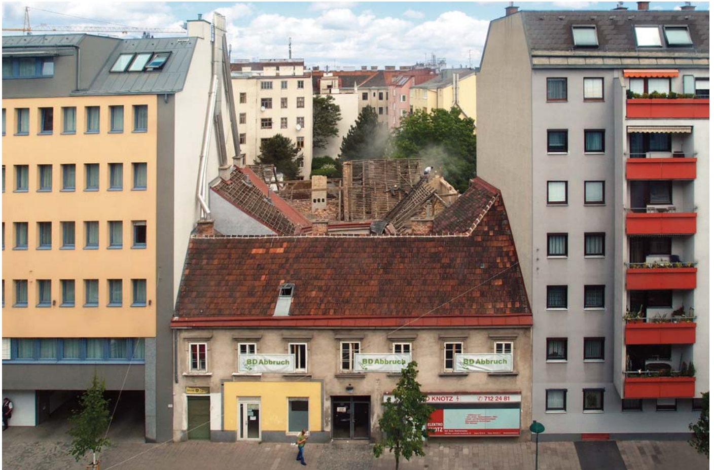
Abb. 74: Landstraßer Hauptstraße Nr.157 während der Abbrucharbeiten, Mai 2015. Es lag keine Schutzzone der Stadt Wien vor.
