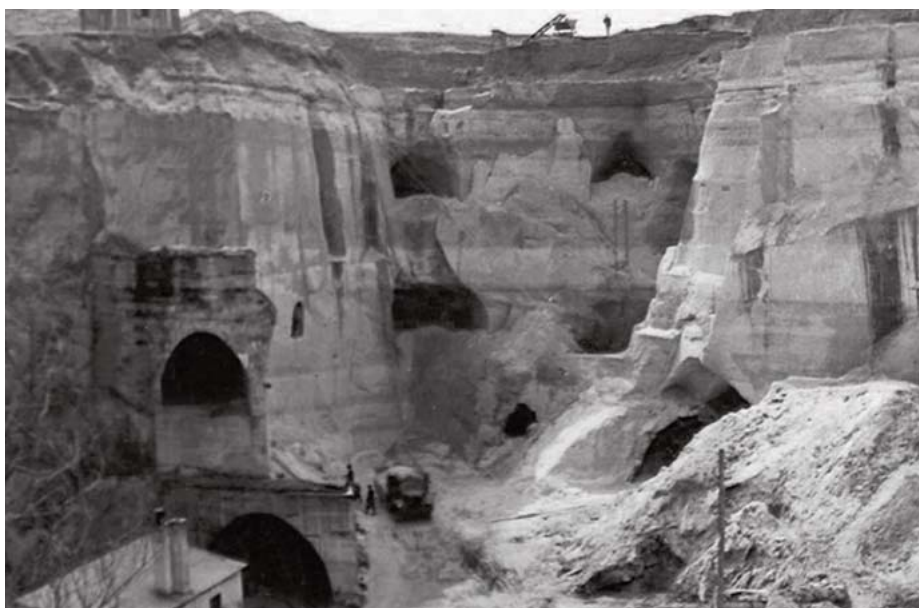
Abb. 67: Noch in den 1960er Jahren waren in der Möglegrube im Bereich des Stollensystems „Bergkristall“ zwei übereinander liegende betonierte Stollenebenen sichtbar (links unten). Die Expertenrunde verneint die Existenz einer zweiten Etage, kann aber das Foto, wie es in der ZDF-Dokumentation gezeigt wird, nicht erklären (vgl. Anm. 5).
