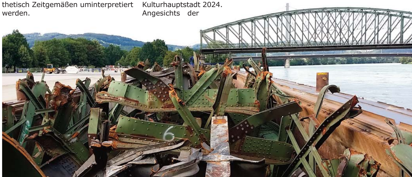
Abb. 62: Die Eisenbahnbrücke während des Abrisses am 3. Juli 2016, „Endstation“ eines außer Frage stehenden Kulturdenkmals.
