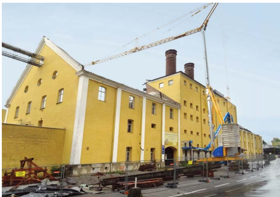
Abb. 83: Der Abbruch der Mälzerei der Brauerei Kaltenhausen im Juli 2016, Ansicht von Salzburg kommend.
