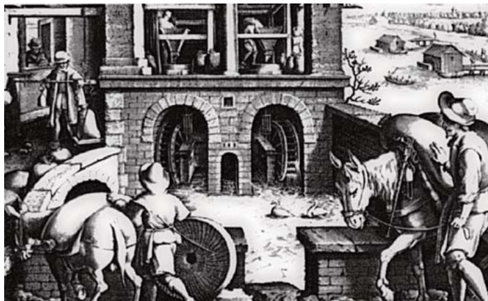
Abb. 1 (li.): Ein Mahltrug aus Stein aus dem 8. Jahrtausend vor Christus, gefunden in Beidha, Jordanien. Schon vor 10.000 Jahren wurde mit einem Stein in der Mulde Getreide gemahlen; Abb. 2 (re.): Eine Abbildung aus dem Jahr 1555 zeigt wassergetriebene Räder eines Aufstaus, die Getreidemühlen antreiben. Rechts im Hintergrund sind in den Strom hinausgebaute Flussmühlen dargestellt.
