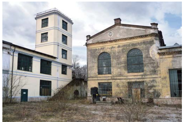
Abb. 90: NÖ - Neunkirchen: NSW (Neunkirchner Schraubenwerke), Wasserturm (li.) u. Maschinenhaus (re.), Foto: 2009
