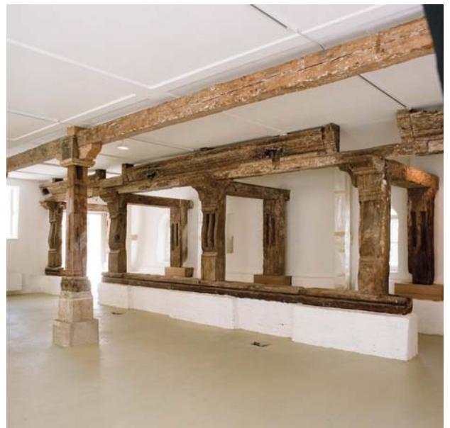
Abb. 9 (li.): Die denkmalgeschützte Heumühle im Innenhof des Gebäudes Schönbrunner Straße 2 (4. Bezirk, Wieden) ist die letzte erhaltene Mühle am Mühlbach südlich des Wienflusses; Abb. 10 (re.): Die zweischiffige, vierjochige Ständerkonstruktion des ehemaligen Mühlwerks nach der 2006 bis 2008 erfolgten Adaptierung des Bauwerks.
