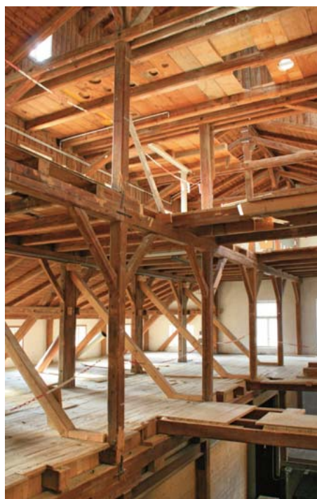
Abb. 53 (li.): Die zum Wohnhaus umgenutzte Grazer Stadtmühle. Architektur: Hans Gangoly (1999), Zustand 2014; Abb. 54 (re.): Das Innere des historischen Silogebäudes der Fisslthaler Mühle mit seinen im Wesentlichen noch erhaltenen Tragkonstruktionen aus Holz, Architektur: P. & A. Crozzoli (1912), Zustand 2014.
