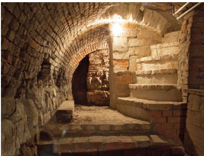
Abb. 17: Der noch bestehende Mühlbach unter dem Haus Lainzer Straße 10. Er verläuft unter dem 1820 errichteten Zubau zum ehemaligen Wohntrakt des Müllers. Vor Errichtung des Zubaus wurde der Werkskanal eingewölbt und nach Schließung der Mühle geriet er in Vergessenheit. 1990 wurde er wiederentdeckt und das Gewölbe unter dem Stiegenhaus aufgebrochen. Gemeinsam mit einem Mühlbachrest neben dem Linienamt an der Linzer Straße und den Mühlbachbrücken im heutigen Park des Europahauses ist er der letzte Zeuge der früher von Mariabrunn bis zum Donaukanal führenden Werkskanäle; Abb 18 (re.): Die Glutmühle in Hütteldorf, Foto: 1930er Jahre.
