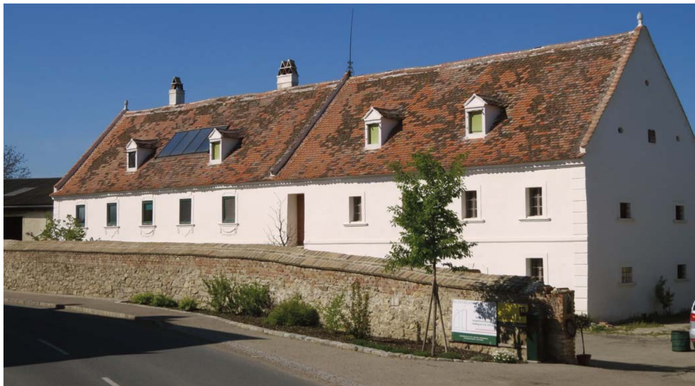
Abb. 57: Straßenfront nach Neufassadierung, Zustand 30.4.2016
