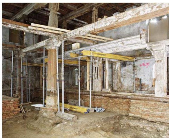
Abb. 11 (li.): Auf der südlichen Pfostenreihe steht im Obergeschoß ein prächtiger Balusterpfeiler (links oben im Bild), der möglicherweise älter ist als die restliche Ständerkonstruktion. (Aufnahme während der Bauuntersuchung 2004); Abb. 12 (re.): Baualtersplan der Heumühle mit Bauelementen aus der Zeit vor 1326 bis zur Gegenwart.
