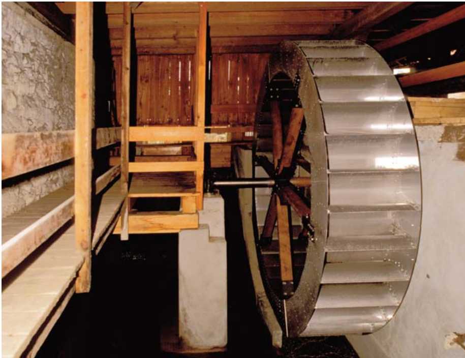
Abb. 6: Die Sägemühle Hegi bei Winterthur (Schweiz). Das bei der Restaurierung eingesetzte neue Wasserrad aus Chromstahl stört den historischen Eindruck, dieses Material ist deshalb unbedingt zu vermeiden.
