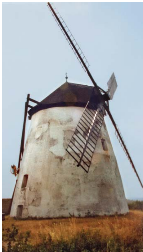
Die berühmte Retzer Windmühle im nördlichen Niederösterreich: Abb.29 (li.o.): Kammrad; Abb.30 (re.o.): Nach der Restaurierung nach einer Darstellung von 1908 sind die Flügel wieder aerodynamisch und betriebsfähig, Mauerwerk einheitlich mit Sumpfkalkputz; Abb.31 (li.): Die Mühle, seit 1928 unter Denkmalschutz, vor der Restaurierung: Flügel nicht mehr drehbar und nicht windgängig, Fassadenbehandlung mit ungeeignetem Putz. Abb.32 (re.u.): Denkmalpflegerische Restaurierung des Kammrades.
