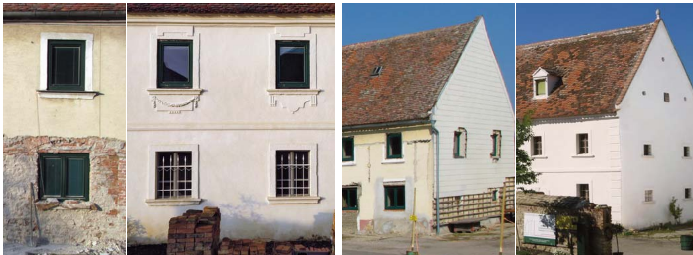
Abb. 59a u. 59b (li.): Fassadenpartie des Wohntraktes vor der Restaurierung (Foto aus 2008) und nach der Restaurierung 2012 mit auf Wiener Zolbasis ausgeführter Fassadengliederung. Die Festons in den Parapetfeldern wurden in Anstragstechnik frei modelliert; Abb. 60a u. 60b (re.): Vergleich der Stirnseite des Wohntraktes, Fotos aus den Jahren 2008 und 2012.
