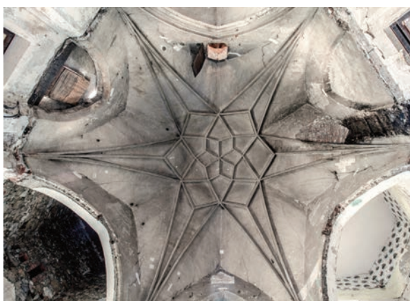
Abb. 95-97: Bei einer Proberestaurierung kamen zuvor unsichtbare Teile einer Inschrift zum Vorschein, die von der Erbauung 1495-1497 berichtet; Das spätgotische Sternrippengewölbe, nachdem die später eingezogenen Zwischendecken entfernt waren (Sept. 2014); Die kurz zuvor entfernten Zwischendecken und die nachträglich eingebauten Wohnungsfenster sind erkennbar (Foto 2013).
