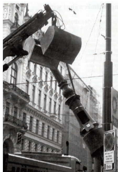
Abb. 32: Mastenwechsel in der Stadiongasse
