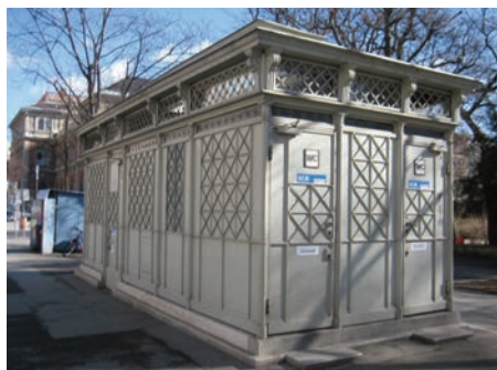
Abb. 41: historische WC-Anlage am Parkring, Ecke Weiskirchnerstraße
