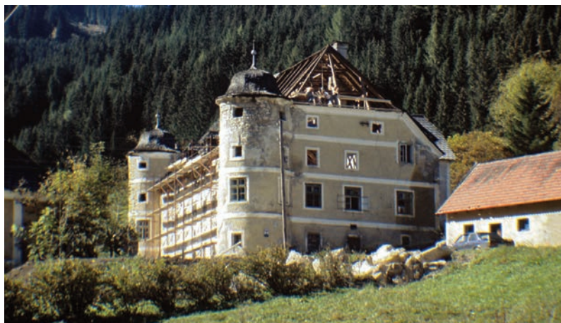
Abb. 106-108: Schloss Greifenberg in der Obersteiermark. Offene Fenster und eingestürzte Zwischendecken im Inneren beweisen den dringenden Restaurierungsbedarf
