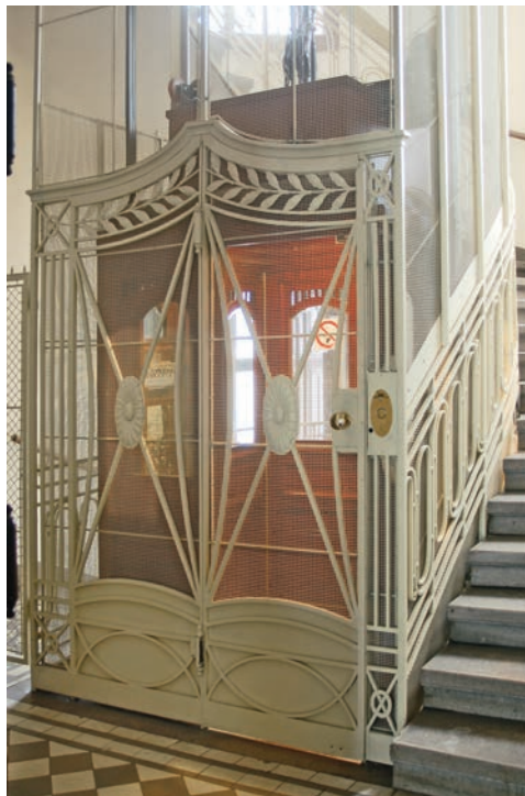
Abb. 52 (li.): Aufzug Henslerstraße 3 in Wien-Landstraße: Das Gitter musste engmaschiger werden, erhielt aber seine ursprüngliche helle Farbe; Abb. 53 (re.): Die inzwischen 108 Jahre alte Kabine aus Mahagoniholz konnte nun doch erhalten werden.
