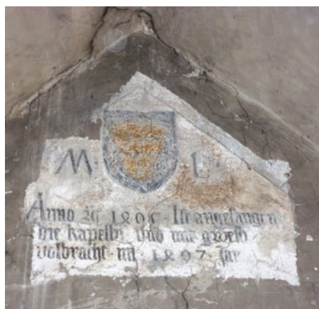
Abb. 95-97: Bei einer Proberestaurierung kamen zuvor unsichtbare Teile einer Inschrift zum Vorschein, die von der Erbauung 1495-1497 berichtet; Das spätgotische Sternrippengewölbe, nachdem die später eingezogenen Zwischendecken entfernt waren (Sept. 2014); Die kurz zuvor entfernten Zwischendecken und die nachträglich eingebauten Wohnungsfenster sind erkennbar (Foto 2013).
