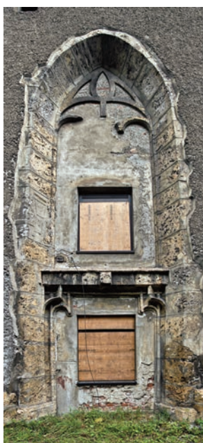
Abb. 98 u. 99: Reste von einem gotischen Fenster an der Südseite (Foto Sept. 2012), das inzwischen wieder als schlankes, hohes Fenster geöffnet wurde; Das ursprüngliche gleichseitige Spitzdach wurde wiederhergestellt.
