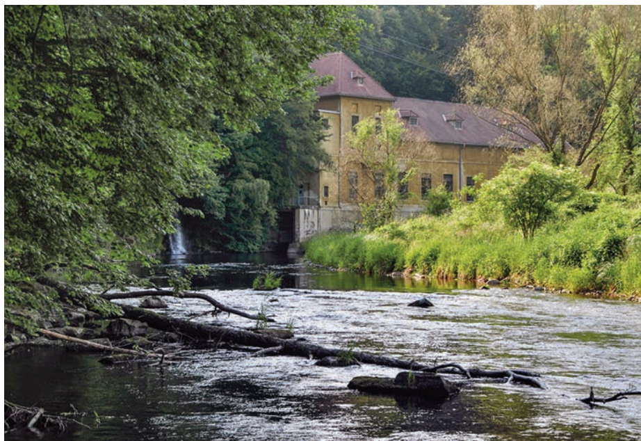
Abb. 105: Blick über den Kamp zum vor über 100 Jahren gebauten, in die Flusslandschaft eingefügten Kraftwerk Rosenberg im Waldviertel (Juni 2015)
