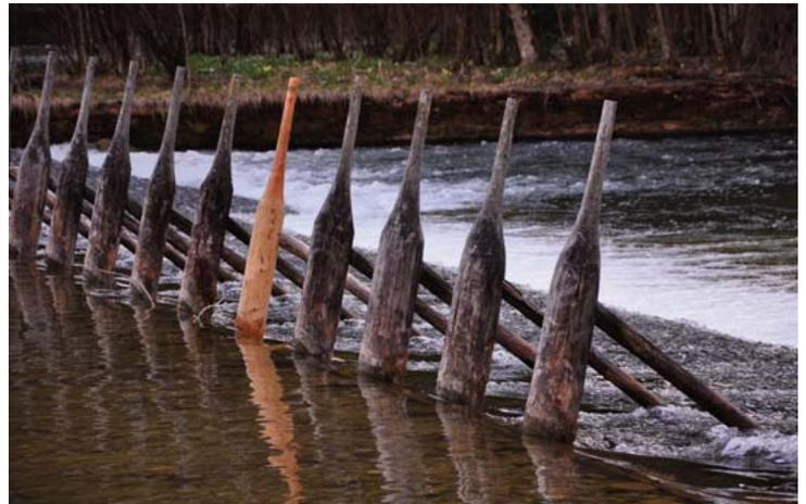
Abb. 51: Der "Polster" besteht aus einem Vierkantholz mit aus dem Wasser ragenden "Doggen", vor denen mit Vorsatzbrettern 40 m unterhalb der Klause ein Stau zur Entlastung erzeugt werden konnte.
