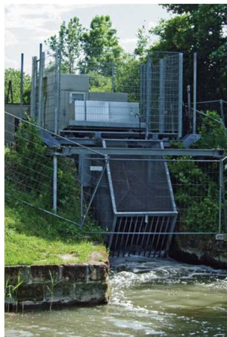
Abb. 9 (li.): Mitte der 1990er Jahre wurden von Mitarbeitern der Abteilung Wasserbau die letzten Tore bei Schleuse 34 nach alten Plänen neu gezimmert; Abb. 10 (re.): Die Schleuse 28 bei Kottlingbrunn wurde 2013 durch den Einbau einer Staudruckmaschine der Firma KBA-Hydro verunstaltet. Da die Mauern dabei erhalten blieben, konnte das Denkmalamt keinen Einwand geltend machen.
