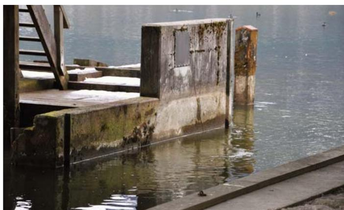
Abb. 52: Automatisches Wehr vom Anfang des 21. Jh., das schlechter funktioniert als das Jahrhunderte alte Original
