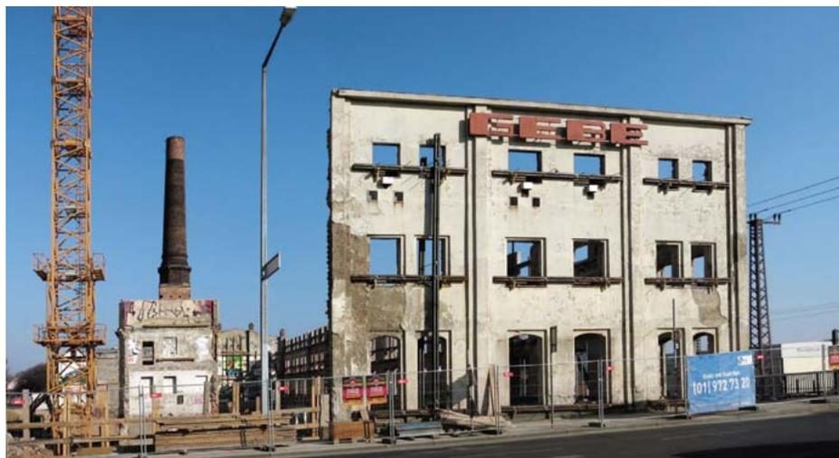
Abb 13 (o.): März 2014: Vom denkmalgeschützten Haupttrakt der GEBE-Fabrik sind nur noch dünne Fassadenreste übrig. Links das ebenfalls geschützte Kesselhaus mit Schlot; Abb. 14 (re.): Denkmalgeschütztes Hauptgebäude der GEBE-Fabrik im September 2012, erbaut 1897. Unter dem Verputz ist die alte Sichtziegelfassade erkennbar.
