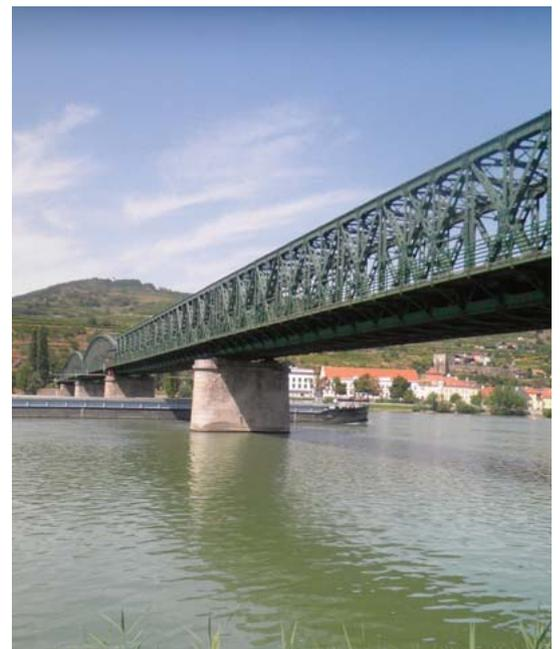
Abb. 25 (li.o.): Imposante, längst verschwundene Brückenportale auf einer Ansicht aus dem Jahr 1900; Abb. 26 (re.o.): Straßenbrücke Stein-Mautern (NÖ) im August 2013, nach der Anhebung zur Beseitigung von Hitzeinwirkungen
