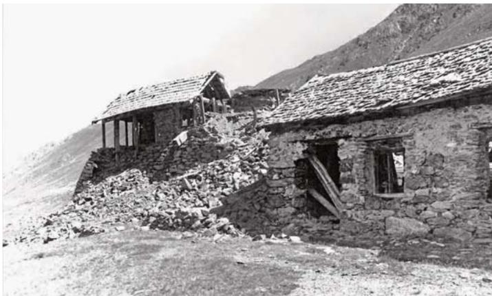
Abb. 54: Zustand der verfallenen Bergstation (links) der Materialseilbahn und der Mannschaftsunterkunft auf ca. 2500 Meter Seehöhe im Platzertal im Jahr 1986 (Dokumentationsfoto BDA)
