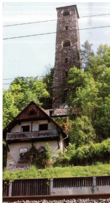
*Abb. 70 u. 71: Im Schrottturm zu Klagenfurt erstarrte flüssiges Blei nach freiem Fall zu kugelförmiger Schrotmunition (rechts: aktuelle Ansicht mit einstigem Restaurant, unten: Lithographie um 1830)*
