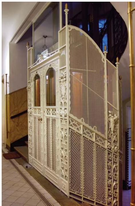
Abb. 85 (li.): Historische Aufzugsanlage im Stadtpark-Hof, Vordere Zollamtsstraße 11 in Wien-Landstraße, vor der Sanierung; Abb 86 (re.): Aufzugsanlage im denkmalgeschützten Stadtpark-Hof nach der vorbildlichen, behutsamen Sanierung mit erhöhter und feinmaschigeren schiedeeisernen Gitterumwehrung
