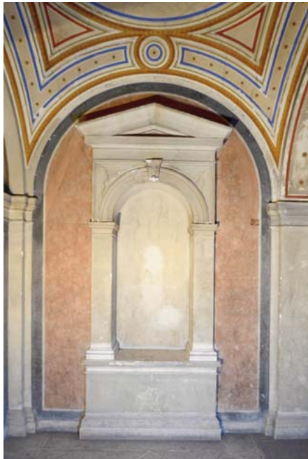
Abb. 61: Stiegenhaus (Ost) Mezzanin, vor der Restaurierung (2012)
