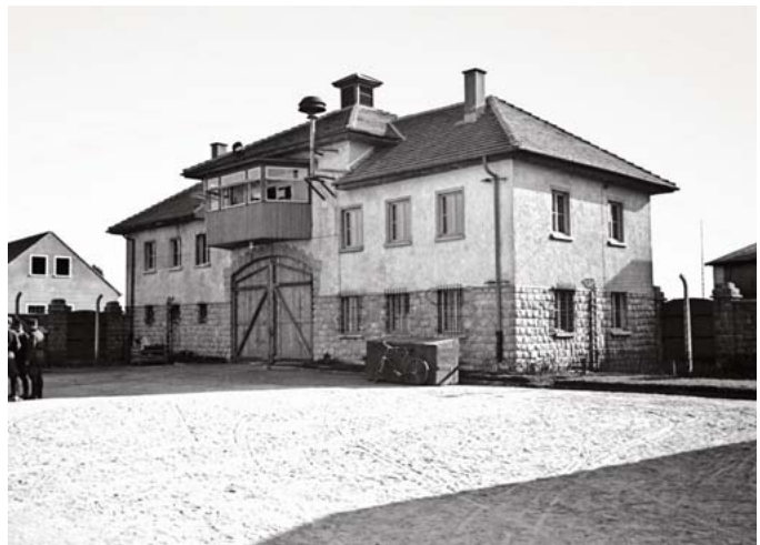
Abb. 7: KZ Gusen I (ca. 1941): Das „Jour-Haus“ der SS wurde nach dem Krieg als Plastikfirma und Wohnhaus „weiterverwendet“, die Granitblöcke der Wachtürme dienten zum 'Häuslebau'.
