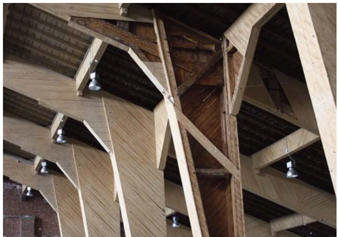
Abb. 35 u. 36: Einsicht in den Aufbau der Nagelbinderkonstruktion der Panzerhalle, (2010)
