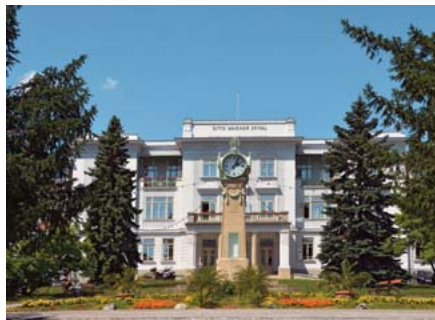
Abb. 86: Wien, Otto Wagner-Spital Steinhof
