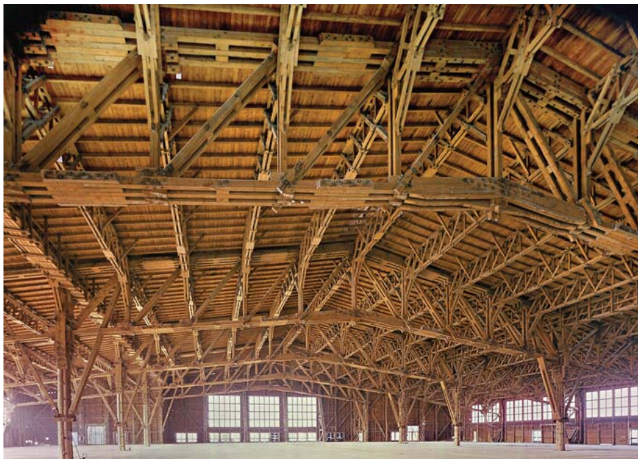
Abb. 43 (li.): Innenansicht vor dem Abbruch: 122 Meter lang, 80 Meter breit, stützenfreies Mittelschiff; Abb. 44 (re.): Wiederaufbau der Halle zu drei Fünfteln der ursprünglichen Länge im Jahr 2007
