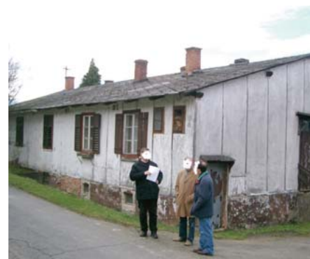
Abb. 84: Arbeitslager in Steinbach, Stmk.
