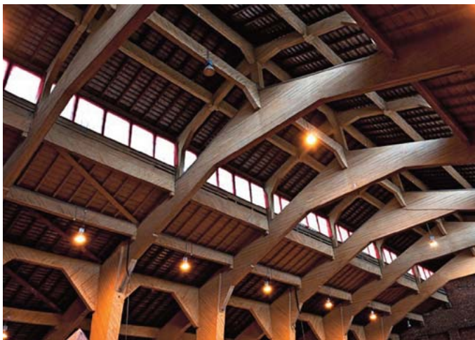
Abb. 35 u. 36: Einsicht in den Aufbau der Nagelbinderkonstruktion der Panzerhalle, (2010)
