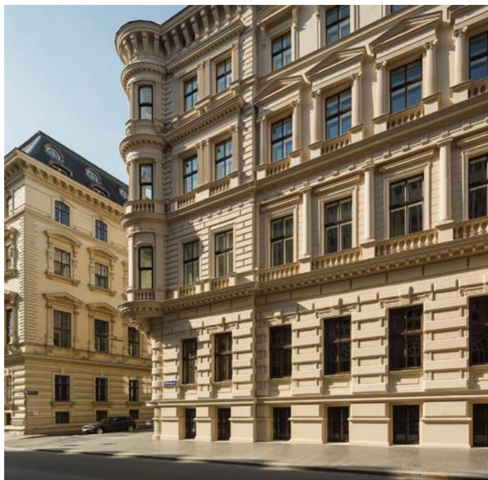
Abb. 59: Das Palais Schwab nach der Generalsanierung 2014
