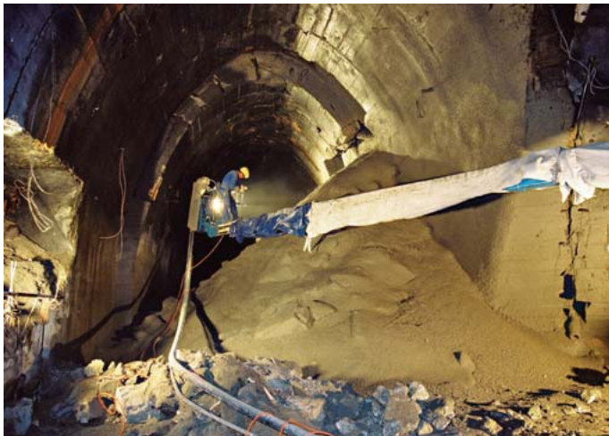
Abb. 51: „Sicherung“ der Stollenanlage „Bergkristall“: Rund 85 Prozent der Anlage wurden ohne vorherige wissenschaftliche Untersuchung mit Beton verfüllt, obwohl der Großteil unter Feldern liegt, und nicht unter Häusern.
