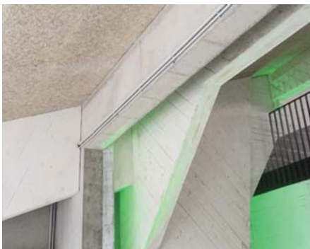
Abb. 38: Auf Marco Sillabers Wunsch weiß gefärbte Nagelbinder-Fakes wurden zwischen die Betonträger des Neubaus geflickt. (Dezember 2014)
