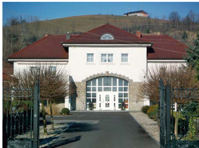
Abb. 50: Nach dem Krieg unangemessene „Nachnutzung“ als Pilz- und Plastikfabrik, sowie heute als Wohnhaus mit Wintergarten.
