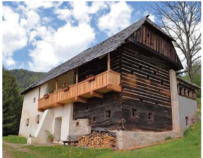
Abb.3: Das Bauernhaus vulgo Giefer in St. Georgen ob Judenburg (Pichlhofen 7) zeichnet sich durch seine Material- und Konstruktionsvielfalt sowie die deutlich ablesbaren Ergänzungen und Erweiterungen aus.
