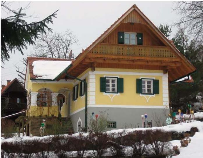
Abb.2: Weststeirisches Bauernhaus, das durch die jüngste Sanierung zwar in der Gesamtform erhalten ist, aber durch massive bauliche Eingriffe und die Verwendung nicht denkmalgerechter Baustoffe seine Denkmaleigenschaften eingebüßt hat.
