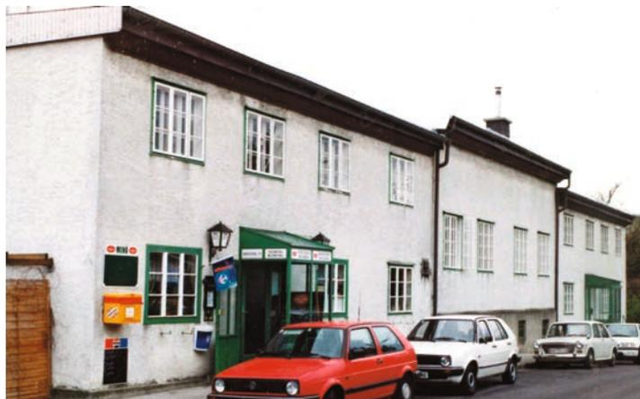
Abb. 16 (o.li.): Die ursprüngliche Holzschindelverkleidung wurde bei vielen Häusern durch Eternitplatten ersetzt (Schrammeltgasse 13, Foto 1998); Abb. 17 (o.re.): Schutzhause Siedlung Heuberg, Röntgengasse 39 (Foto 1998)
