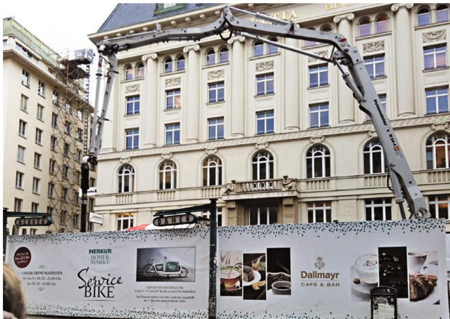
Abb. 68: Beginn der Betoneinfüllung über Kranarm und Schläuche in die historische Bedürfnisanstalt (23.9.2013)
