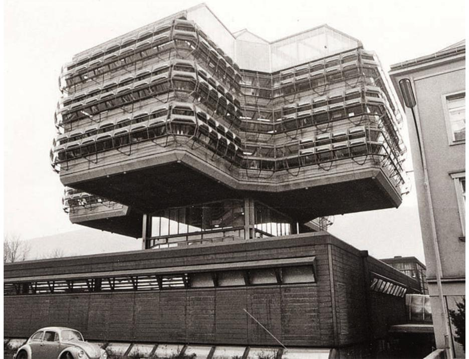
Abb. 45 (o.): Das Forschungs- und Rechenzentrum in den 1970er Jahren: Ein markantes Bauwerk mit Corten-Stahl-Fassade; Abb. 46 (li): Dasselbe Gebäude heute, nach dem Umbau: Glatte Standard-Fassade und Verlust des unverwechselbaren Baucharakters
