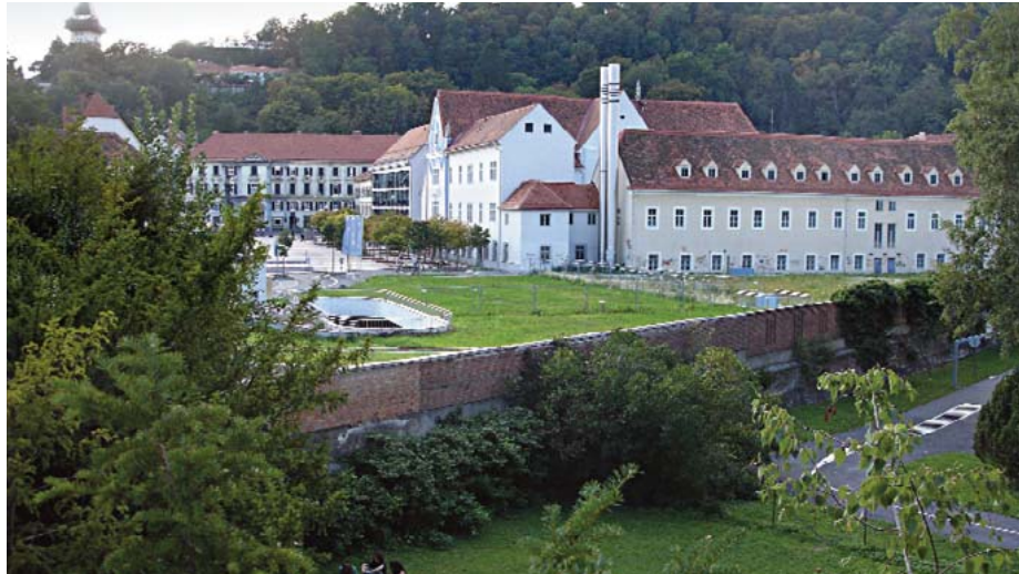
Abb. 103: Tiefgarage unter dem Pfauengarten
