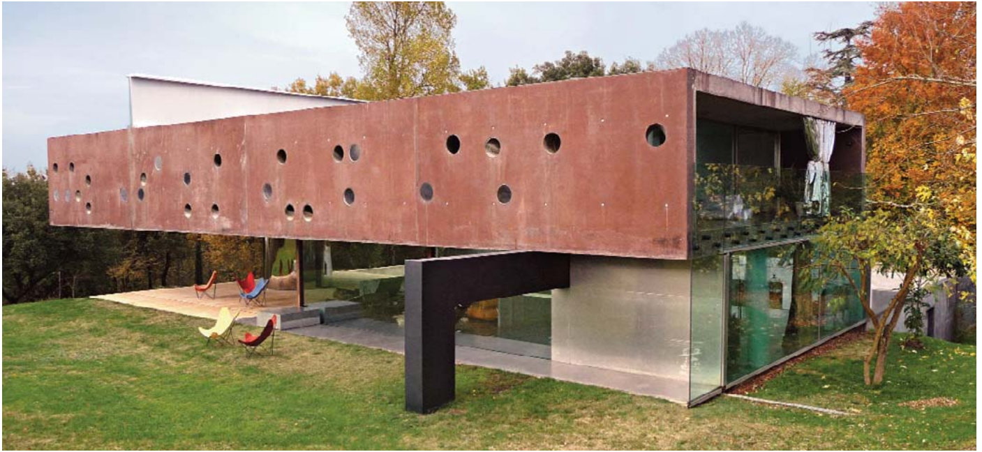
Abb. 39: Haus Lemoine, Floirac bei Bordeaux, Architekt Rem Koolhaas, errichtet 1994 bis 1998. ISMH - also eingeschrieben im Denkmalinventar - kaum vier Jahre nach der Fertigstellung
