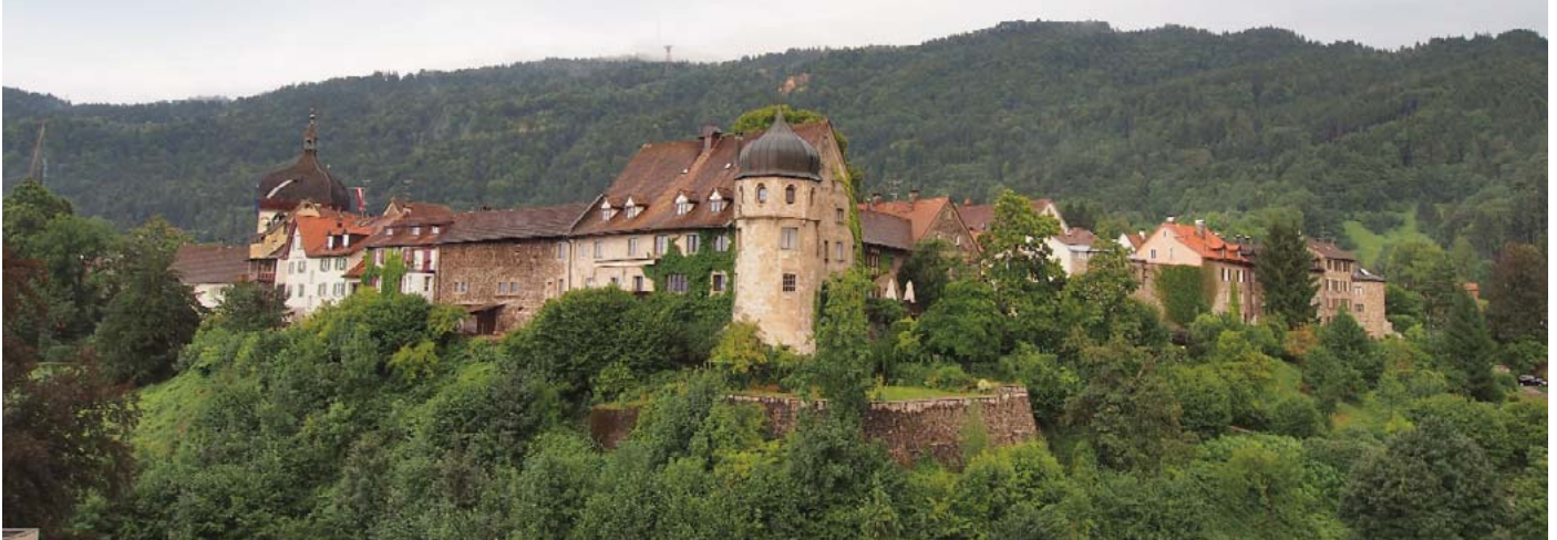
Abb. 107: Deuringschlössle oberhalb von Bregenz; am Abhang war ein monumentaler Aufzug und ein containerartiges Bauwerk geplant. Nun denkt man an einen dezenten Schrägaufzug oder einen Aufzug im Berg.
