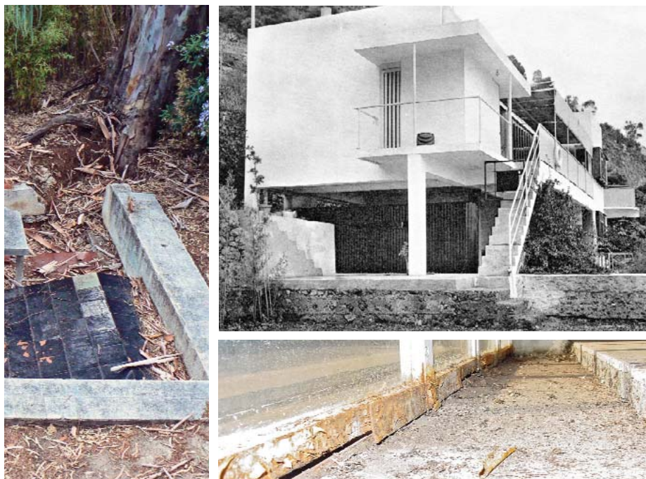
Abb. 40-42: Haus "E 1027" der irischen Architektin Eileen Gray in Roquebrune - Cap Martin (französische Riviera), errichtet 1927 bis 1929, Mängel bei der Restaurierung: Solarium im Garten, heutiger Zustand. Auf eine dringend notwendige Restaurierung wurde zugunsten des wild gewachsenen Baums verzichtet (li.), Terrassentüren im Salon. Die Metallschiebetüren wurden nach dem Krieg verkürzt und eine Schwelle eingebaut. Zustand heute, keine zwei Jahre nach dem Rückbau (re.u.)
