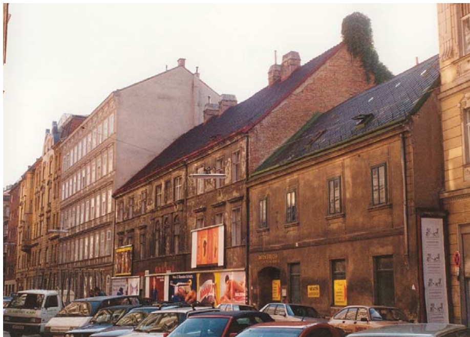
Abb. 49: Vorstadthäuser Hahngasse 11 und 13 (Wien-Alsergrund) im Jahr 1995 vor dem Abbruch. Erbaut Anfang 19. bzw. 2. Hälfte 18. Jh.
