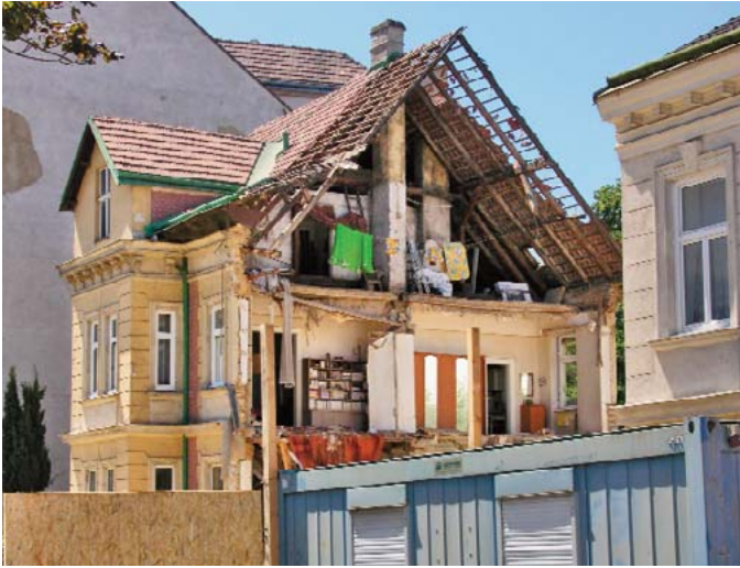
Abb. 58 (links): Einsturz einer Haushälfte auf Kendlerstraße 27 (August 2010) durch Bauarbeiten am Nebengrundstück. Heute werden beide Grundstücke durch einen Neubau derselben Immobilienfirma genutzt; Abb. 59 (rechts): Neustift am Walde 88 vor der Zerstörung: Fassadenabriss im Juli 2013 nach Einsturz der Hausrückseite durch eine Baustelle am Grundstück
