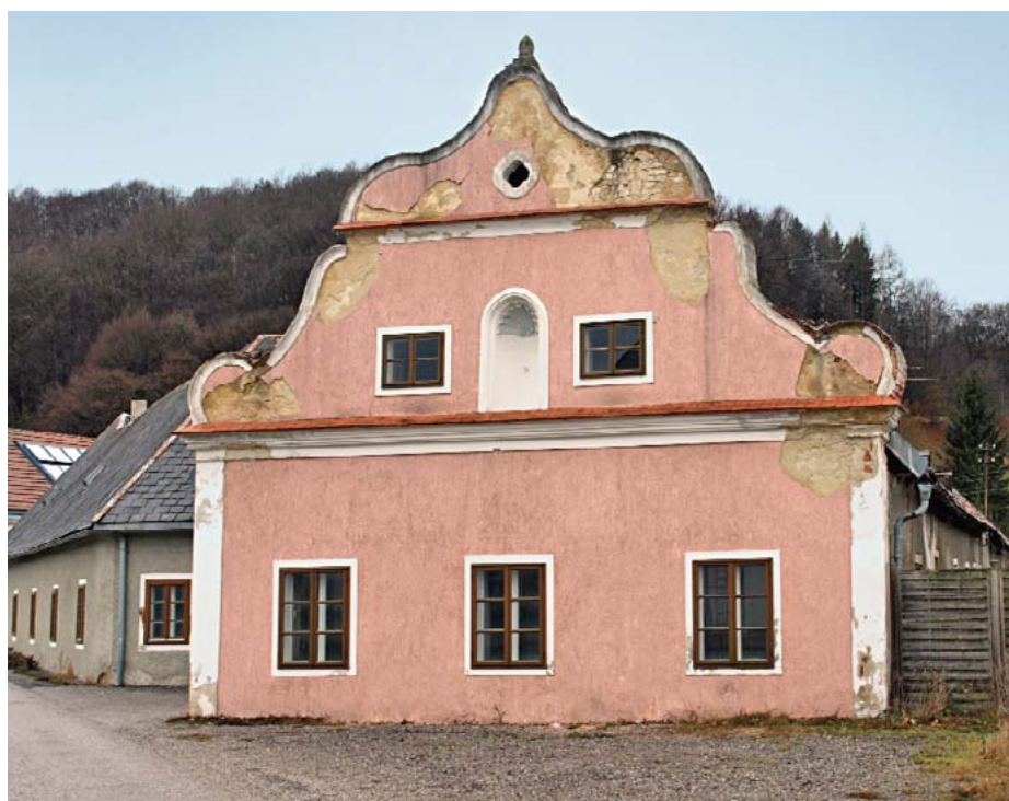
Abb. 34: Das rund 300 Jahre alte Peinstadlhaus (Färbergasse 28, Wilhelmsburg, NÖ) im Dezember 2012. Inzwischen steht nur mehr die geschützte Ostfassade und ein seitlicher Mauerteil, der Rest wurde gegen die Empfehlung des Denkmalbeirats (DMB) zerstört.
