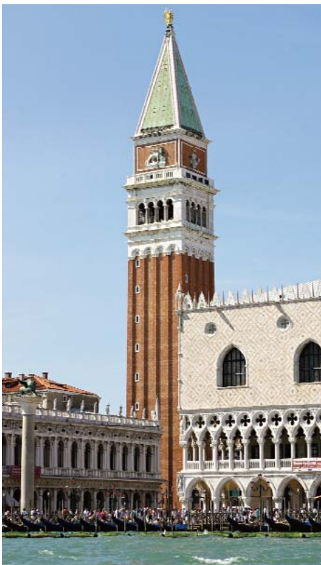
Abb. 53: Der ab 888 errichtete Campanile in Venedig stürzte 1902 ein und wurde ab 1903 vollständig neu errichtet
