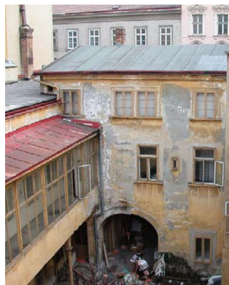
Abb. 51: Mariannengasse 22 (Wien-Alsergrund), erbaut 1773, später umgebaut, vor dem Abbruch im Februar 2003
