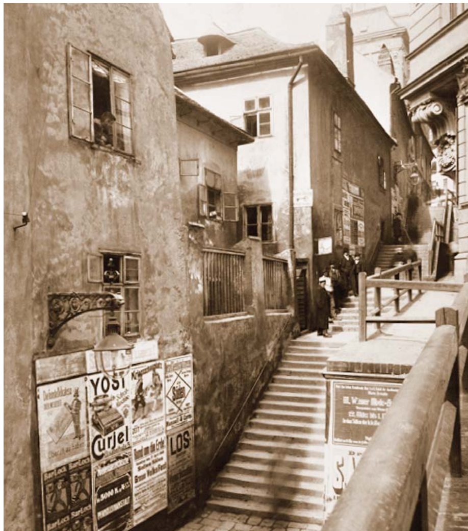
Abb. 47: Königslosterstiege in Wien-Mariahilf (vor 1905). Der Fotograf August Stauda dokumentierte im Auftrag des Präsidenten des Vereins für Denkmalpflege und Heimatschutz, Graf Karl von Lanckoroński, gefährdete „Alt-Wiener“ Bausubstanz.
