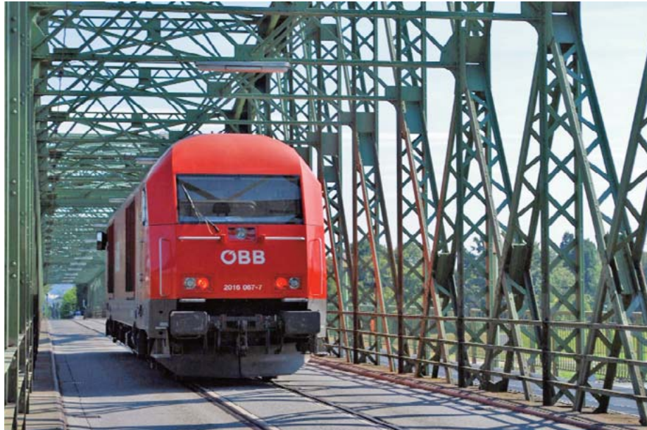
Abb. 36: Linzer Eisenbahnbrücke, erbaut 1900, mit ungewöhnlicher genieteter Eisenfachwerkkonstruktion, angelegt für Bahn- und KFZ-Verkehr, hier mit rotem Siemens Diesellokomotive, Modell Rh 2016 „Hercules“. Abbruch scheint bereits beschlossene Sache. Das BDA hob gegen die Empfehlung des DMB den Denkmalschutz auf.
