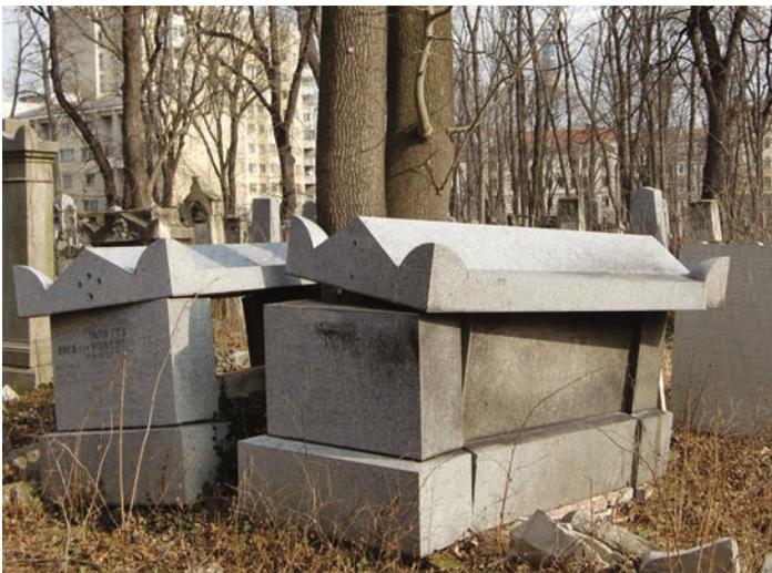
Abb. 10: Problematischer Wurzelwuchs: Hier hebt eine wild aufgegangene Esche zwei Kenotaphe aus. Die Sanierung von Baum und Grabdenkmälern stellt hinsichtlich technischem Aufwand und Kosten hohe Anforderungen an Professionisten.
