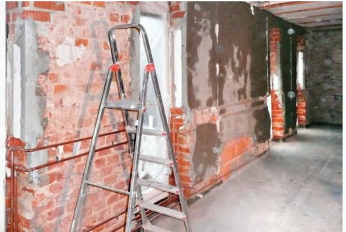
Abb. 30: alternative Rohrverlegung, vgl. Abb. 29
