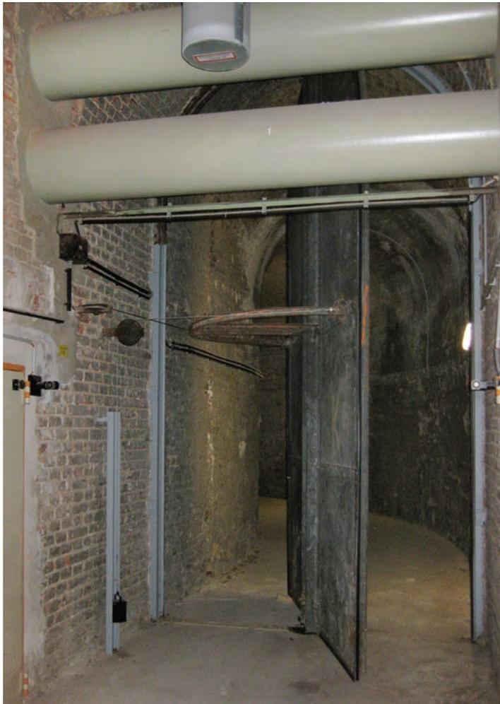
Abb. 43: Die Drehtür im 2. Keller der Neuen Burg dient zur kontrollierten Zuluftsteuerung
