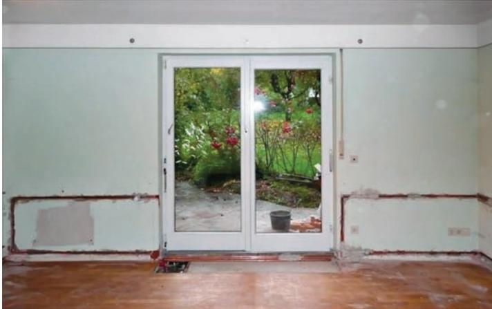
Abb. 33a: Westwand, Rohrführung im Bereich der Außentüre
