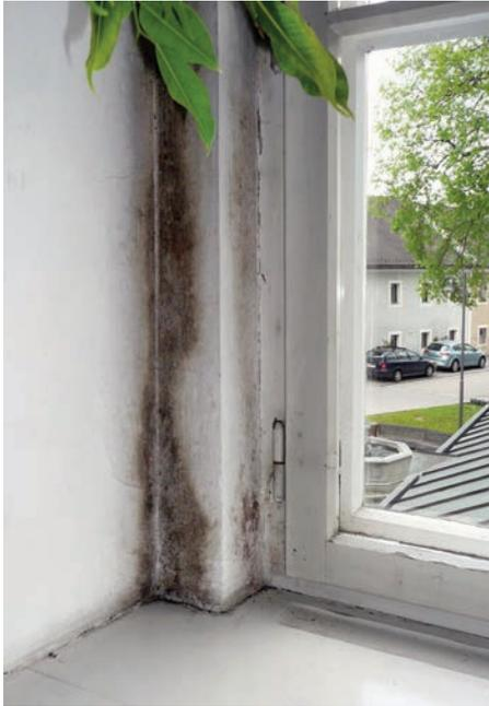
Abb. 5: In diesem barocken Pfarrhof wurden bereits mit dem Einbau der Verbundfenster anstelle von Kastenfenstern extreme Schwachstellen in den Fensteranschlüssen geschaffen. Seit dem zusätzlichen Einbringen von Dichtungen breitet sich plötzlich Schimmel aus. An den Fenstergewänden ist es nun nicht nur besonders kalt sondern auch sehr feucht. Isolierglas stellt hier keine Lösung dar. Vielmehr ist die Verbesserung der Mauerlaibung notwendig – z.B. mit dem Rückbau des ursprünglichen Fensterkastens
