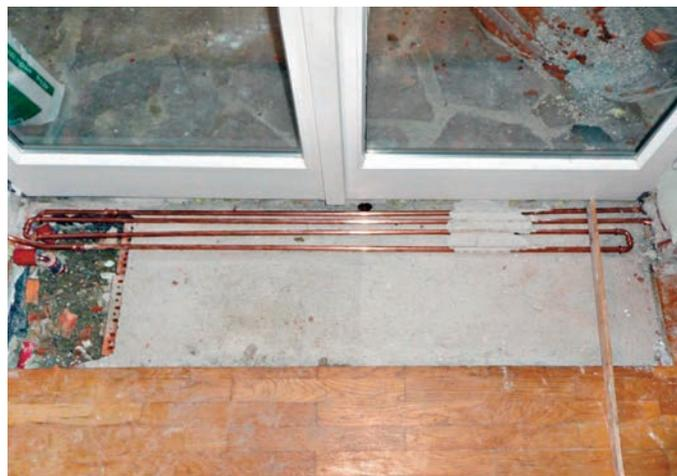
Abb. 32: Türbereich mit doppeltem Rohrregister
