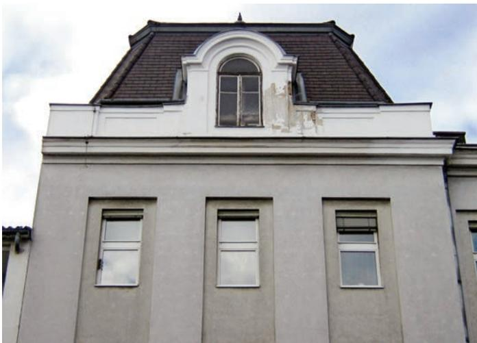
Abb. 3: Die Architektur des historistischen Amtshauses wurde durch Vollwärmeschutz zerstört. Die Attikazone ist nicht gedämmt aber auch nicht instandgesetzt worden. Eindringendes Regenwasser verursachte offensichtlich die deutlich sichtbaren Schäden.
