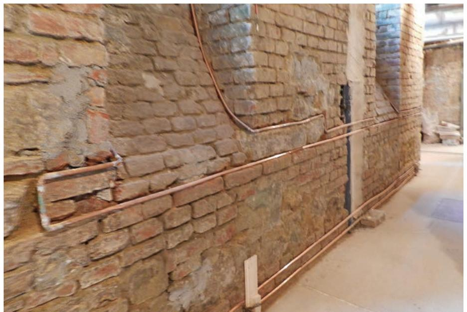
Abb. 17: 1150 Wien Jadengasse, Souterrainlokal. Temperierrohre an einer Außenwand, vor dem Verputz. Das Bild auf S. 1 zeigt den linken Teil der Wand mit der Raumecke
