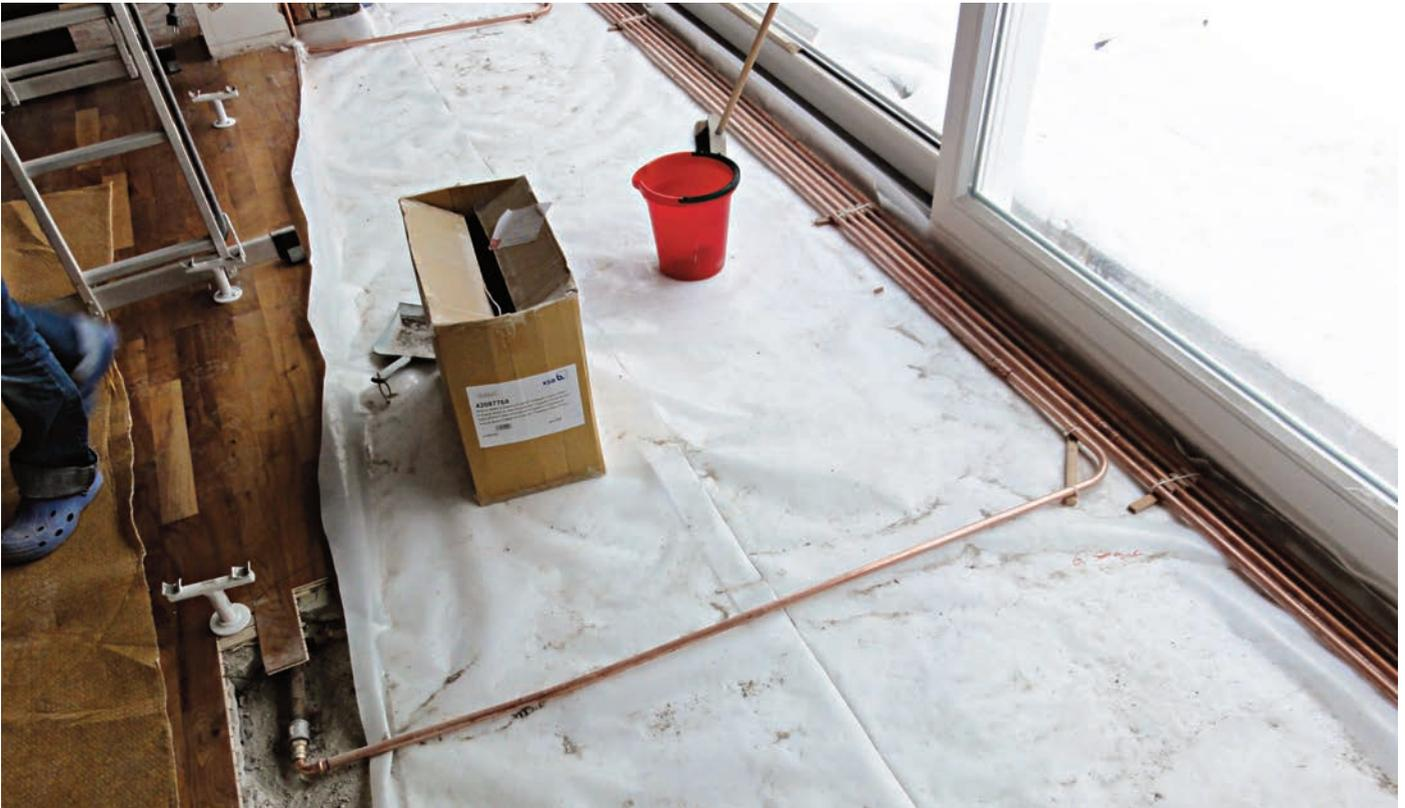
Abb. 35: Erweiterung eines Wohnraumes von 1969: Ersatz des großen Gliederheizkörpers durch 4 entlang der neuen Fensterwand verlegte Heizrohre (Anschluss an alter Verteilung). Der auf der Folie bis zum Fenster geführte neue Estrich bettet die Rohre scheidelbündig ein, so dass die Natursteinauflage auf den Rohren und die Parkettergänzung höhengleich sind.
