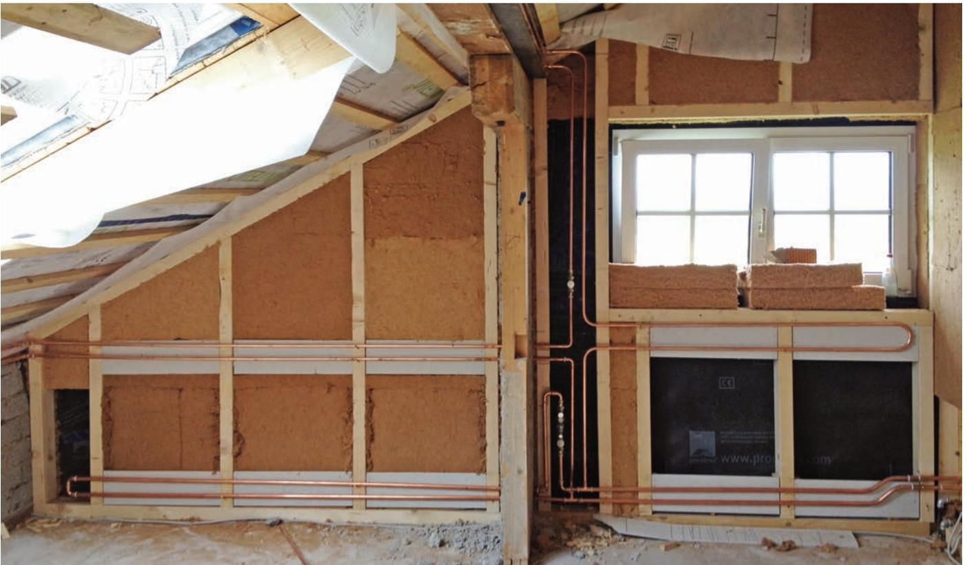
Abb. 36: Temperierung im Leichtbau mit je 1 Sockelschleife um eine Geschoßhälfte und je 1 pro Raum davon abzweigenden Brüstungsschleife (hier verlängert entlang der "Mittelpfette": T-Träger, in den die Verlängerung eingemörtelt wird). Nach Verlegung von OSB-Platten zw. den Schleifen werden die Schleifenbereiche ausgespachtelt und die Gesamtfläche mit Trockenputzplatten belegt.
