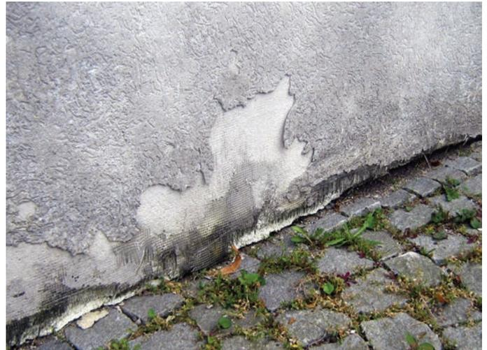
Abb. 4: Der Vollwärmeschutz endet über dem Traufpflaster. Das Oberflächenwasser dringt hier ein, wird vom Mauerwerk aufgesogen und kann nicht mehr austrocknen. Die Oberfläche hält der mechanischen Beanspruchung im Sockelbereich nicht stand.
