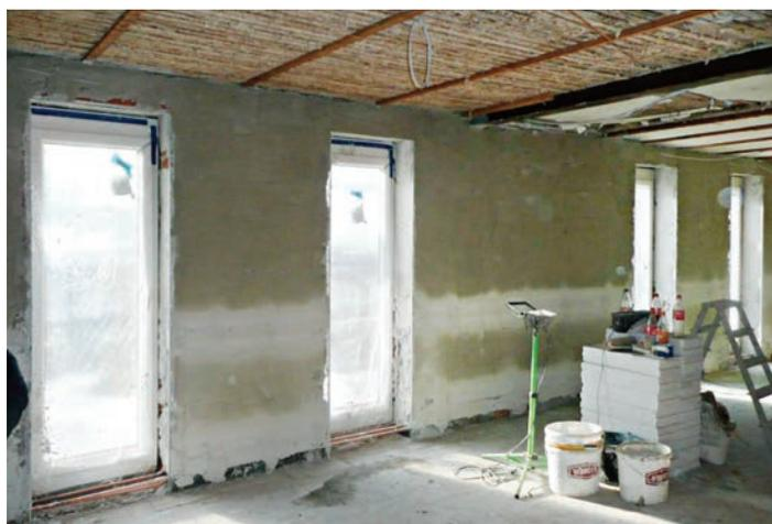
Abb. 31: Wand von Abb. 30 nach Maschinenputz-Auftragung
