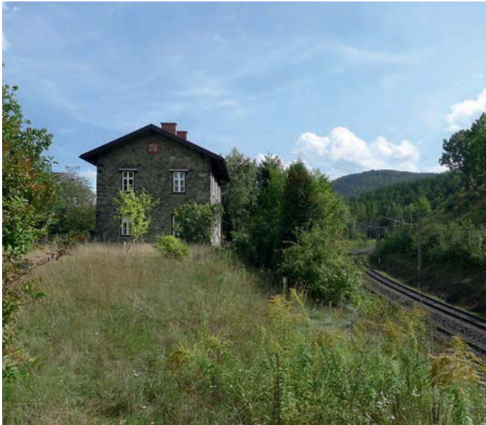
Abb. 28: Wächterhaus Nr. 137, Fenster in Sechserteilung mit Grazer Stock und geschweiften Verblendung
