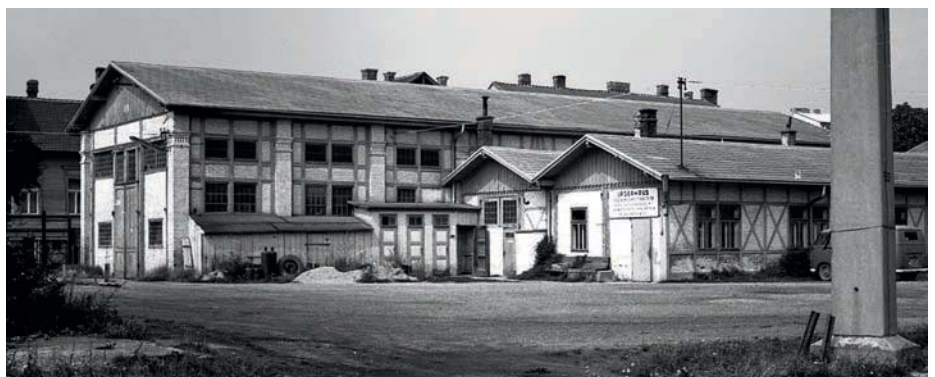
Abb. 40: Die große Wagenremise, sowie die Lokremise und die kleine Wagenremise der „Hinterbrühler Elektrischen“. Der Wert der kleinen Gebäude aus der Ursprungszeit der Bahn wurde leider nicht erkannt, und so fallen sie 1987 dem Projekt Park-and-Ride-Anlage zum Opfer (Foto: 1967)
