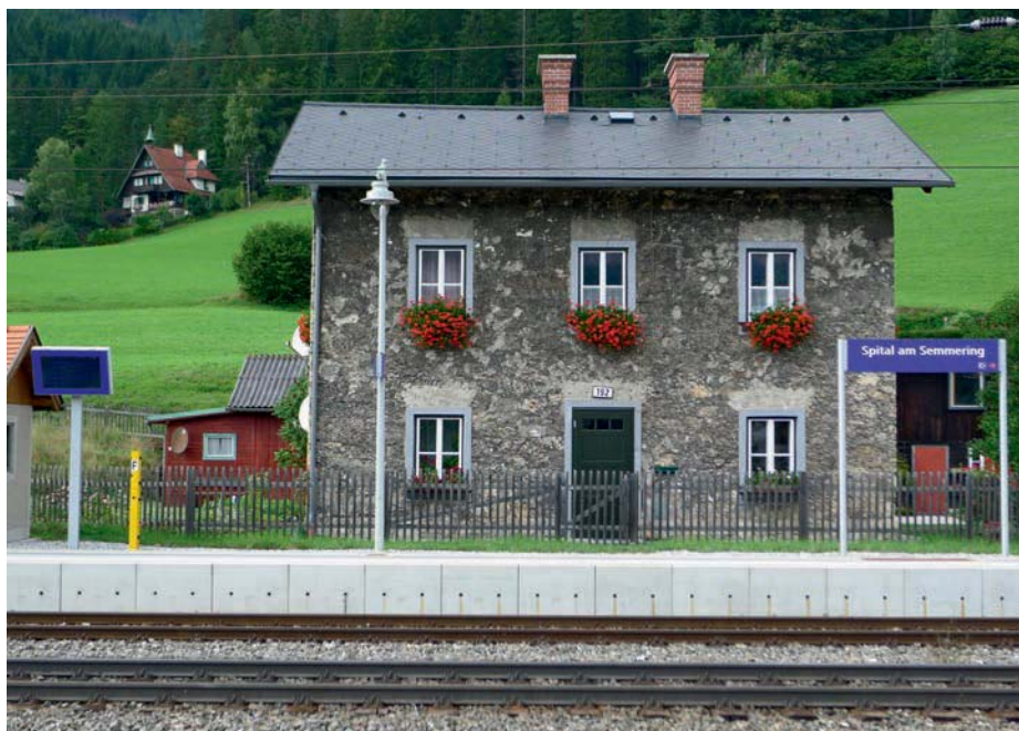
Abb. 27: Wächterhaus Nr.192, Fenster mit Viererteilung, Wiener Stock u. Putzfaschen
