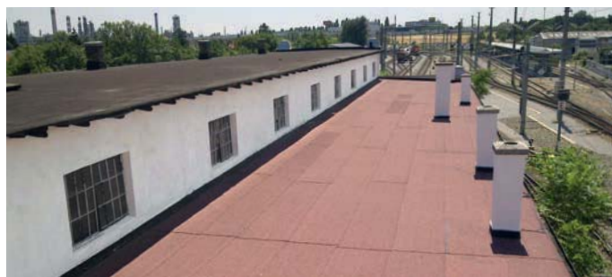
Abb. 36 (o.) und 37 (u): Das Dach der Schwechater Werkstättenhalle vor und nach der Sanierung
