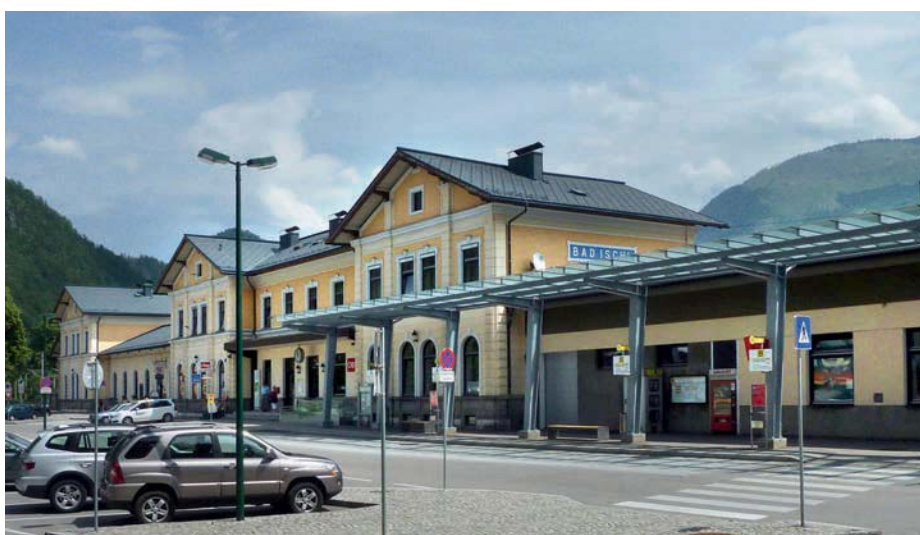
1877, Oberösterreich: Salzkammergutbahn – Bahnhof Bad Ischl (Abb. 8)
