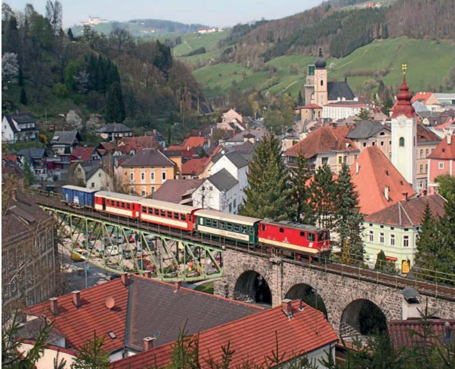
Abb. 34: Der Schwarzbachviadukt der Ybbstalbahn prägt das Stadtbild von Waidhofen/Ybbs (Foto: 2007)
