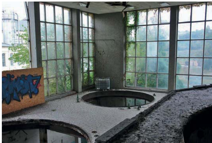
Abb. 55: Das Sudhaus des Simmeringer Brauhauses vor dem Abbruch (um 2005)
