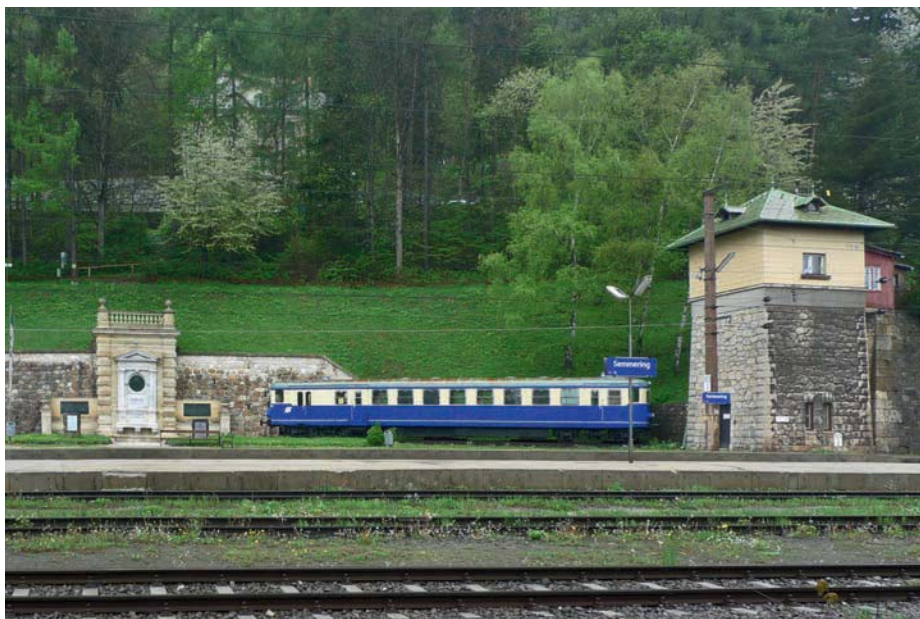
1854, Niederösterreich / Steiermark: Semmeringbahn (Abb. 7)
