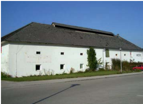
Abb. 63: Erdpresser Hof „Moar in da Au“
