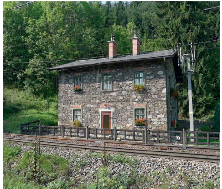
Abb. 29: Wächterhaus Nr. 153, Fenster in Sechserteilung mit Wiener Stock und Putzfaschen
