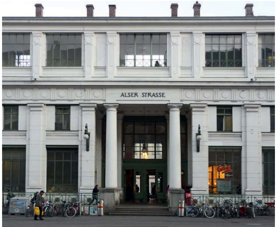
Abb. 42: Hochbahnhof Alser Straße als Torbautyp
