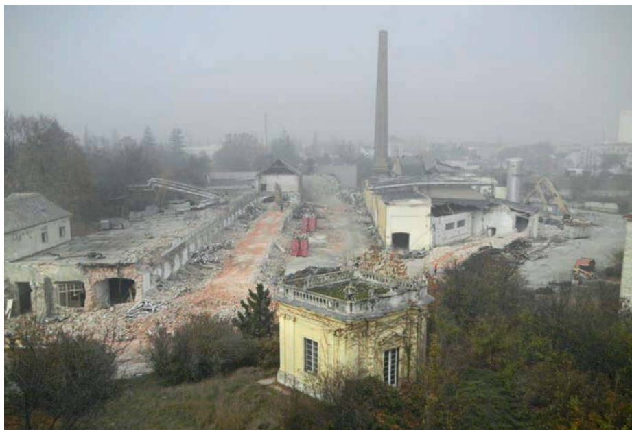
Abb. 52: Blick vom Getreidespeicher auf Pavillon und Brauerei (November 2011)
