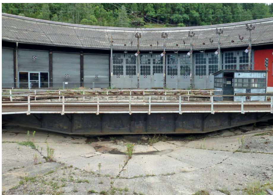
1878, Steiermark: Südbahn – Rundheizhaus Mürzzuschlag (Abb. 9)
