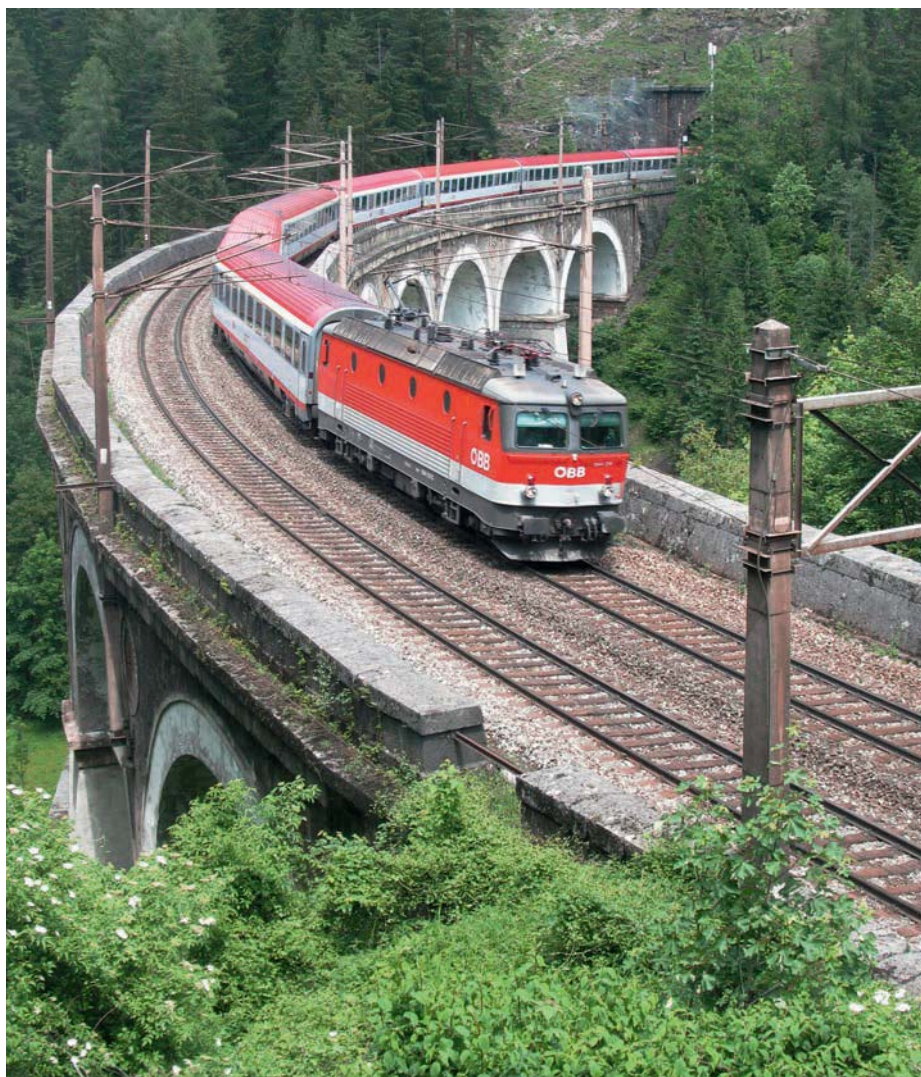
Abb. 25: Ein IC-Zug auf dem Kalte-Rinne-Viadukt der Semmeringbahn
