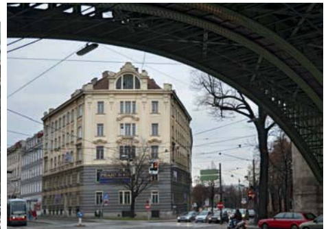
Abb. 65: Haus am Döblinger Gürtel 1
