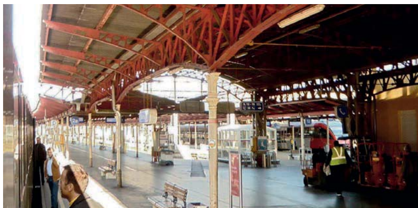
Abb 46 (oben): Schürzenbinder der wieder aufgebauten Bogenhalle (Foto Jän. 2012) und Abb. 47 (unten): Perrondach der an die große Bogenhalle anschließenden Seitenhalle mit Kragarm (Foto vor Demontage, 2008)
