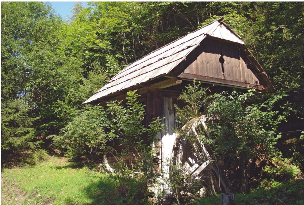
Abb. 27: Stöcklbauermühle: Vulgo Stöckelbauer / Siebenhofer – Rantental bei Murau - Die Abbildung zeigt eine ca. 150 Jahre alte Getreidemühle mit oberschlächtigem Wasserrad. Das Objekt wurde zur Mehlproduktion in eine Hofanlage aus Wohnhaus, Stall- und Wirtschaftsgebäuden eingegliedert. Im Jahre 1964 wurde die Mühle auf Grund eines schweren Hochwassers beschädigt und stillgelegt. 2009 begannen erste Instandsetzungsarbeiten
