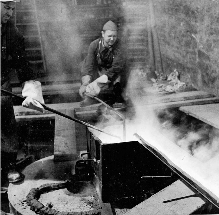
Abb. 35: Guss einer 6000 kg - Glocke: die geschmolzene Glockenbronze fließt in die Glockenform.
