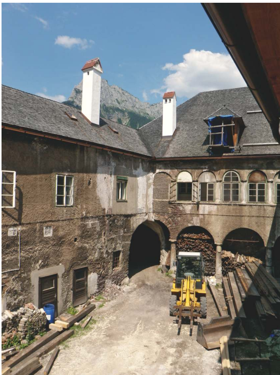
Abb. 18: Blick in den Innenhof des Schwarzer Hofes in Eisenerz. Dieser Bagger stand Gott sei Dank im Dienst der Österreichischen Baukulturstiftung.
