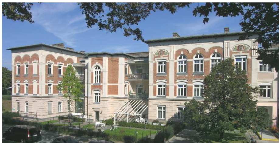
Abb. 41: Einer der typischen Pavillonbauten des Versorgungsheims Lainz
