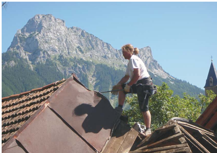
Abb. 19: Dachdeckerarbeiten auf dem Schwarzer Hof
