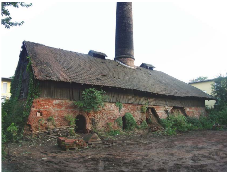
Abb. 6: Die Ziegelei Dörfler in Leoben, erbaut um 1893; 2008 wurde mit der Sanierung begonnen.
