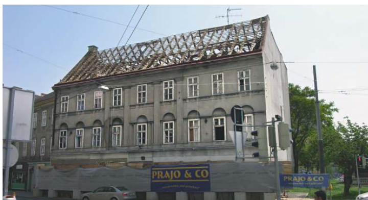
Abb. 47: Abriss des Biedermeierhauses Gumpendorfer Straße 157
