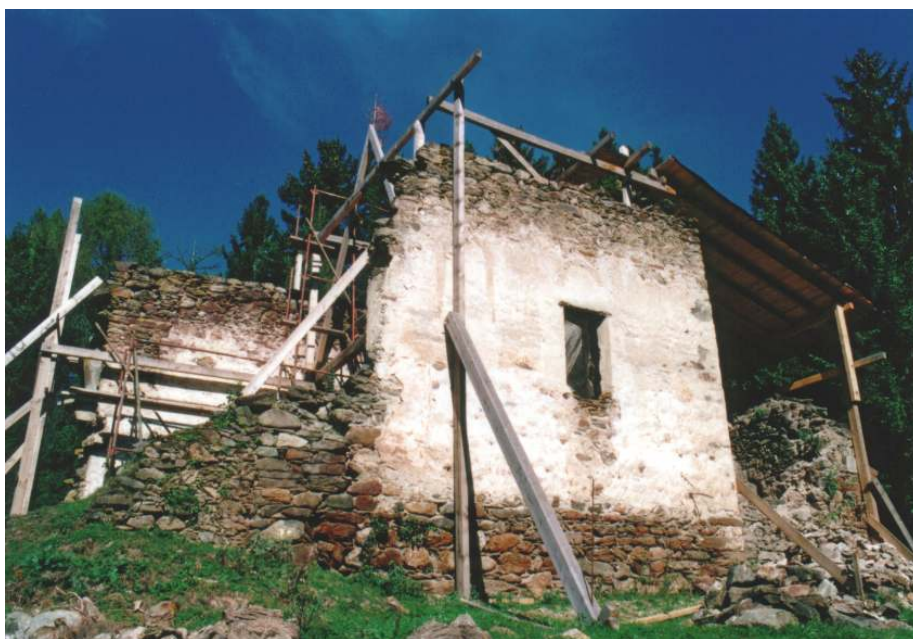
Abb. 4: St. Jakob am Mitterberg zu Beginn der ersten Restaurierungsarbeiten
