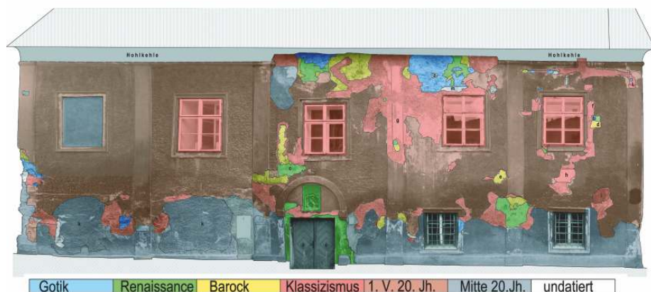
Abb. 14: Fotogrammetrische Abbildung der Fassade des Schwarzer Hofes mit Einzeichnung der Bauphasen
