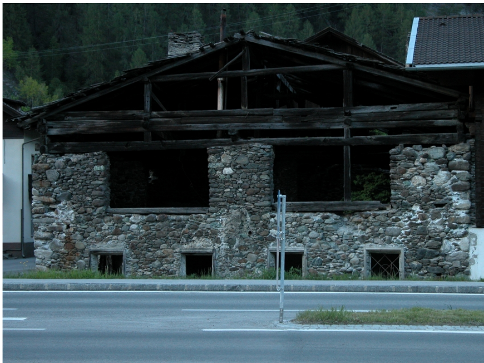
„Kohlbarren“ / Zinkhütte Döllach Gemeinde Großkirchheim Aufnahme 2004, M. Ranacher
