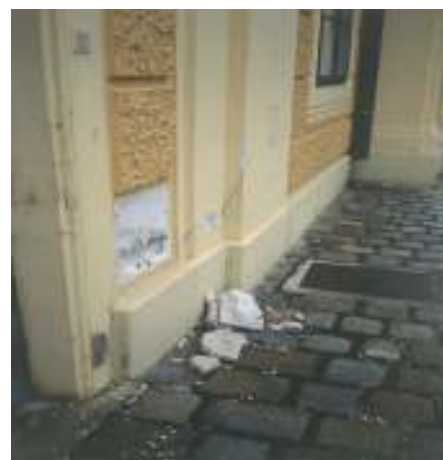
Abbildung 6b: Wagenburg in Schönbrunn, Eingang zur Restaurierwerkstätte. Die unterlassene Feuchtesanierung führte zum Absprengen des neuen „Sanierputzes“, Zustand 1995. Aufnahme Autorin.
