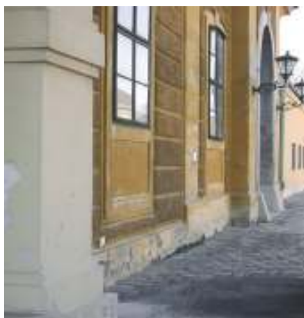
Abbildung 6a: Wagenburg in Schönbrunn, Gebäude mit Feuchteschäden, Zustand 1995. Aufnahme Autorin.
