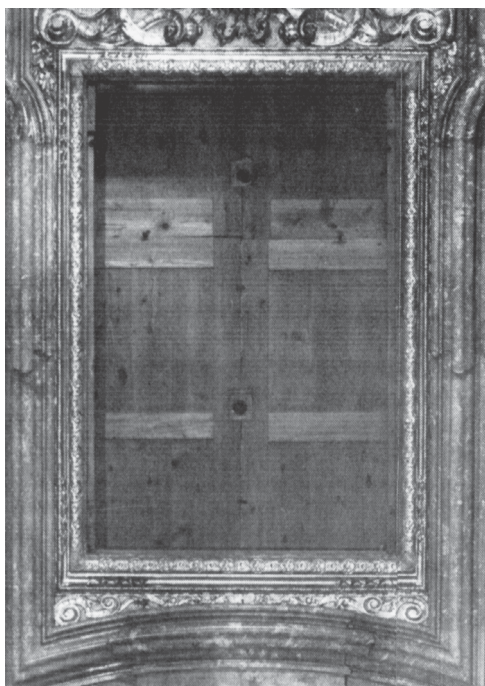
Abbildung 14b: Stiftskirche Melk, Epiphaniekapelle, originale Klimanische mit Holzvertäfelung und wandseitigem Lüftungskanal mit Lüftungslöchern, der von unten nach oben in das Fenster mündet, Zustand 1978. Aufnahme Inge Kirchhof, BDA, Wien.
