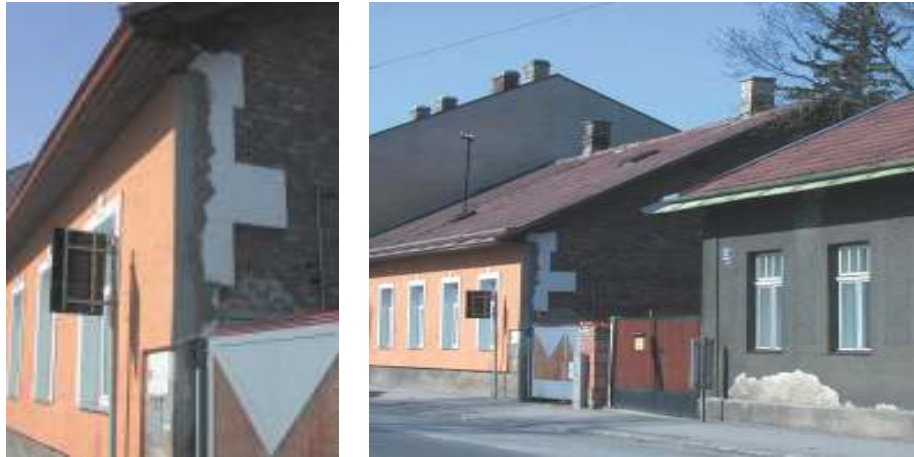
Abbildung 22a + 22b: Wien-Inzersdorf, Purkytgasse 12. Zwei Häuser Anfang 20. Jh.. Das Haus auf der linken Seite hat an der Straßenfassade das Wärmedämmverbundsystem, eine 5cm starke Beschichtung von Putz auf Styropor über dem alten Putz aufgebracht, das rechte Haus ist im Vorzustand mit altem Putz. Aufnahmen März 2003, Autorin.
