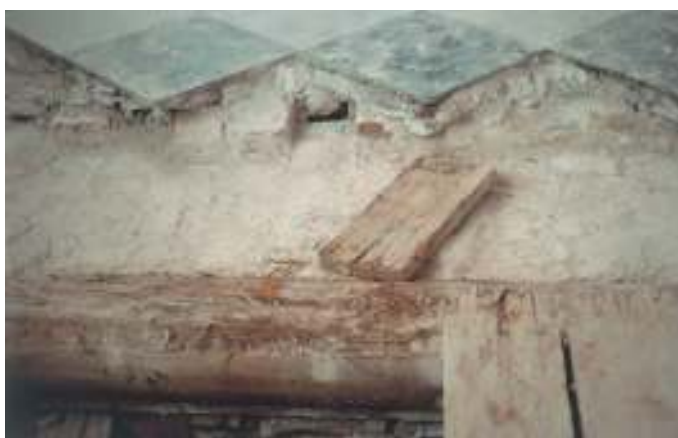
Abbildung 5a: Schloß Schleißheim bei München, Festsaal, Marmorboden mit Unterboden (18.Jh.). Die Dippelbäume und Bodenbretter sind durch Fäulnispilze angegriffen. Zustand 1991. Aufnahme Autorin.
