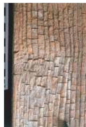
Abbildung 5b: Bauholz mit Würfelfäule aus der technologischen Muster-sammlung der Abteilung für Konservierung und Restaurierung von Denkmälern des Bundesdenkmalamtes Wien. Detail, Aufnahme 1980, Autorin.
