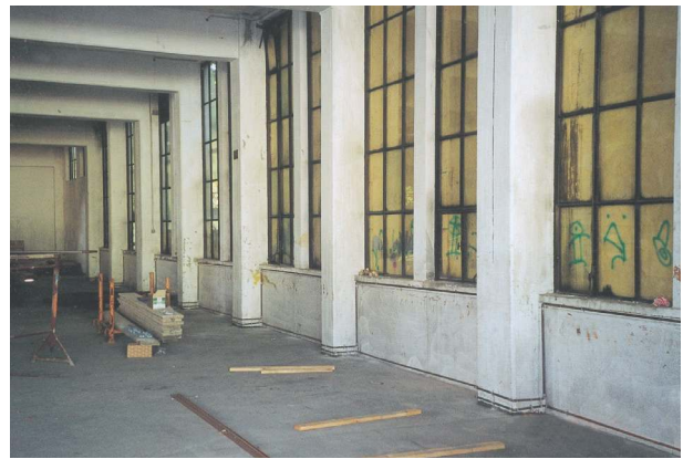
Abbildung 25: Alf Lechner Museum, Ingolstadt, Erdgeschoß. Südwestwand mit Sockel- und Brüstungsheizrohren (Ø 18 mm) vor dem Aufputzen der Brüstungen und dem Anbetonieren des Sockelprofils.
