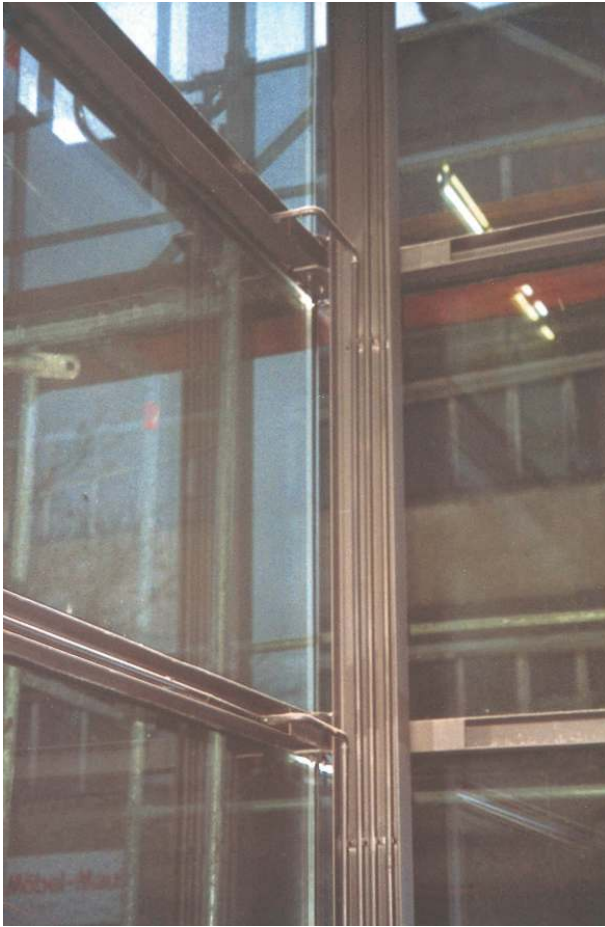
Abbildung 29: Alf Lechner Museum, Ingolstadt, Nordostecke des Glasvorbaus von innen. Im Eckständer Zuleitungen zu den beiden Rohrschleifen der Fassade (Ø 18 mm) in Höhe der Geschosse (EG: 3. und 4., OG.: 6. und 7. Querprofil des Glashalteapparates). Alle Leitungen angestrichen und in Kunststoffclips gehalten. Links Vorlauf (im unteren) und Rücklauf (im oberen U-Profil) der EG-Schleife.
