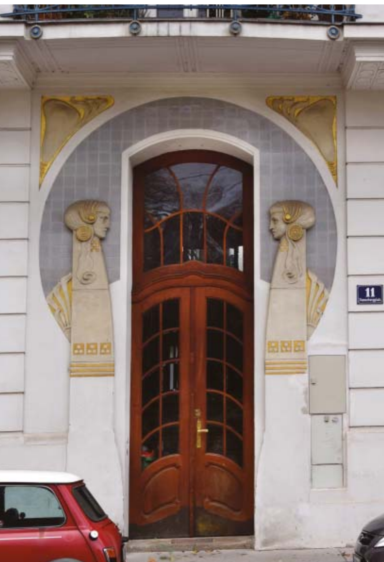
Abb. 31 (o.): Dannebergplatz 11: Ein Baujuwel im reinsten Jugendstil.
