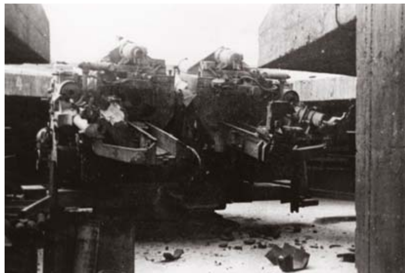
Abb. 19 u. 20: Zur Abwehr alliierter Bomber: Flakstand am Gefechts-turm im Arenbergpark mit einer 12,8-cm-Fliegerabwehrkanone. Dieses Geschütz konnte bis zu 20 Kilometer entfernte Ziele treffen.
