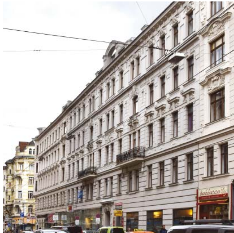
Abb. 8 (o.): Ein Opfer der Kasernenauflassung innerhalb des Gürtels war die 1905 abgebrochene k.k. Fuhrwesenskaserne (auch Trainkaserne genannt) in der Ungargasse (heute Nr. 51-59). Auf dem Areal zwischen Ungargasse und dem Arenbergpark entstanden die Wohnbauten der Dapontegasse, Engelsberggasse und Riesgasse im Stil des Späthistorismus.
