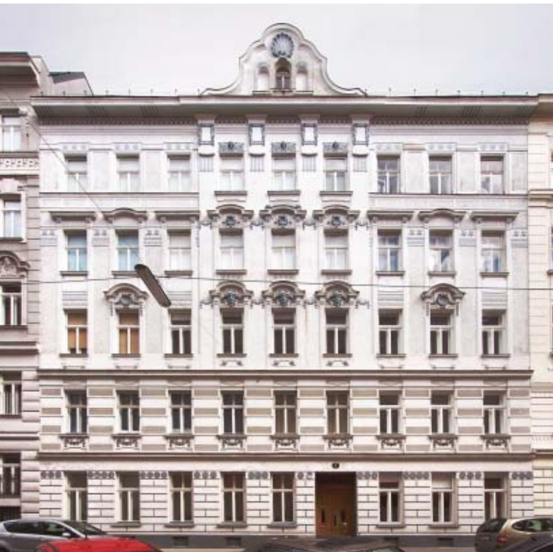
Riesgasse 3: Architekt Max Döring . Giebel mit Jakobsmuschel (Abb. 53, o.li.) Fassadendetail (Abb. 54, m.) u. Fassade (Abb 55, u.), mit Girlanden und Mädchenmasken geschmückt. In Abb. 56 (o.m.) ist das Stiegenhaus zu sehen. Auch die Wände im Hausflur sind eindrucksvoll mit pflanzenartigem Dekor verziert, Abb. 57 (o.re.).
