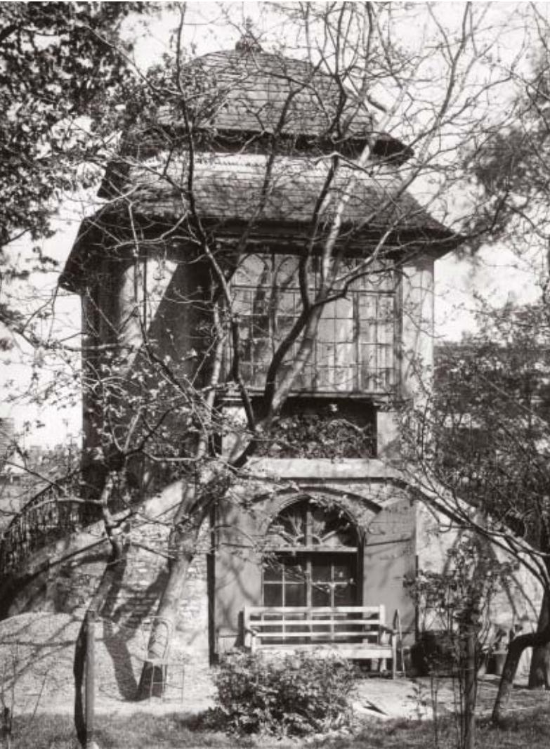
Abb. 25: Ein verstecktes Baujuwel aus der Zeit um 1800: der Pavillon hinter einer Mauer entlang des Fußgängerdurchgangs von der Ungargasse 37 zur Charasgasse, Foto ca. 1905 (vgl. heutiger Zustand in Abb. 121).
