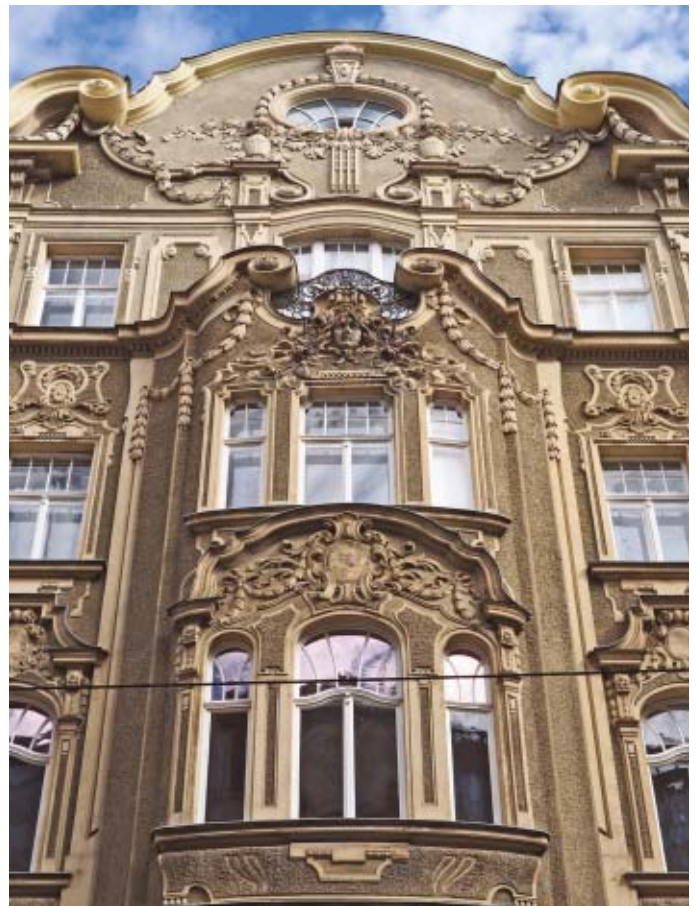
Abb. 45: Dapontegasse 6-8: Architekt Leopold Fuchs . Exzessives Schwelgen in neobarocker Pracht mit plastischer Fassadengestaltung, Figuren, Ranken, Girlanden und Vasenaufsätzen.
