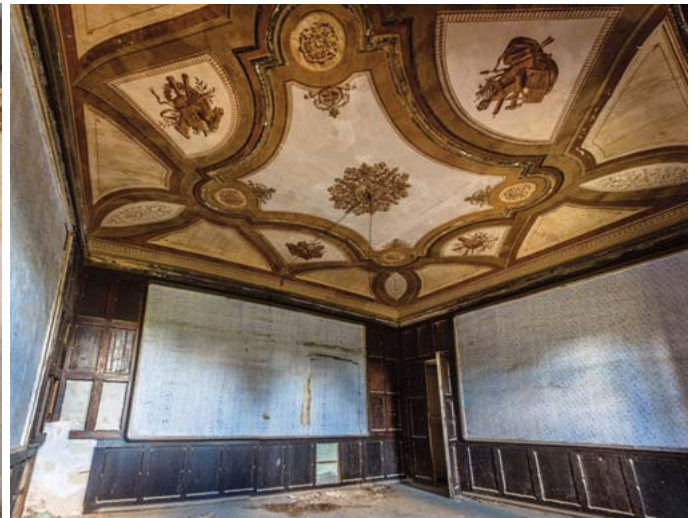
Abb. 6 (li.o.): Schloss Ladendorf: Die einsturzgefährdete Stuckdecke im Festsaal wird mittels Holzpölung gesichert. Teile der prachtvollen Figurendarstellungen (am linken Bildrand) sind bereits abgestürzt.; Abb. 7 (re.o.): Schloss Ladendorf im Weinviertel (Pol. Bez. Mistelbach): Dieses Foto von 2007 zeigt mit Plastikfolie abgedichtete Fenster an der Gartenfassade. Inzwischen kann dort teilweise wieder Regen und Schnee eindringen; Abb. 8 (li.u.): Schloss Ladendorf: Die Schlosskapelle auf einem Foto aus Wikipedia. Als die Tochter des Schlossherrn dort 1756 heiratete, waren die Herrscherin Maria Theresia und der junge Thronfolger Joseph (II.) anwesend; Abb. 9 (re.): Eine der imposanten Saaldecken, die wegen der offenen Fenster durch Feuchteschäden bedroht ist.
