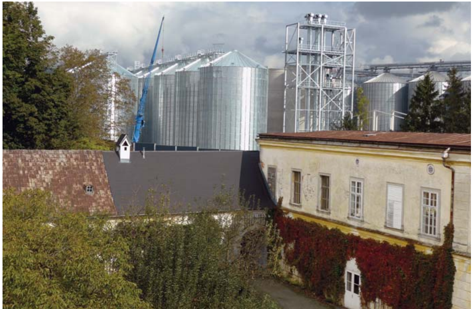
Abb. 73 (o.li.): Die ersten Silos sind im August 2016 bereits errichtet, für die noch folgenden sind die Fundamente vorbereitet. Rechts im Bild ist die im Bau befindliche Schutzmauer zu sehen, hinter der Schloss Aschach verschwinden wird; Abb. 74 (o.re.): Blick vom Schloss Aschach auf die 2016 errichteten weiteren Silos mit Lagerkapazitäten für insgesamt 160.000 Tonnen Getreide; Abb. 75 (re.): Der Komplex des Schlosses bildet einen unechten Vierkant mit einem weitflächigen Hof, der aus einem zweigeschoßigen Seitenflügel und ebenerdigen Anbauten an den dreigeschoßigen Haupttrakt hervorgegangen ist. Hier sind die Arkaden des Haupttraktes zu sehen.
