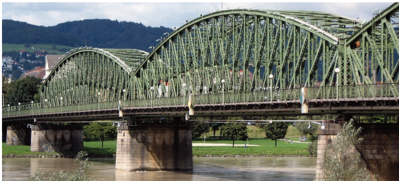
Abb. 61: Die Linzer Eisenbahnbrücke im heutigen Zustand
