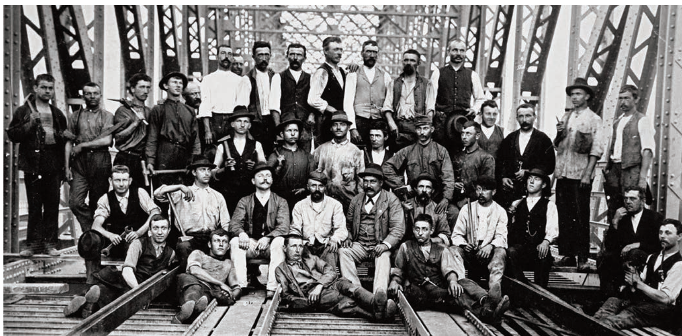
Abb. 60: Arbeiter beim Bau der Linzer Eisenbahnbrücke, Foto aus 1900
