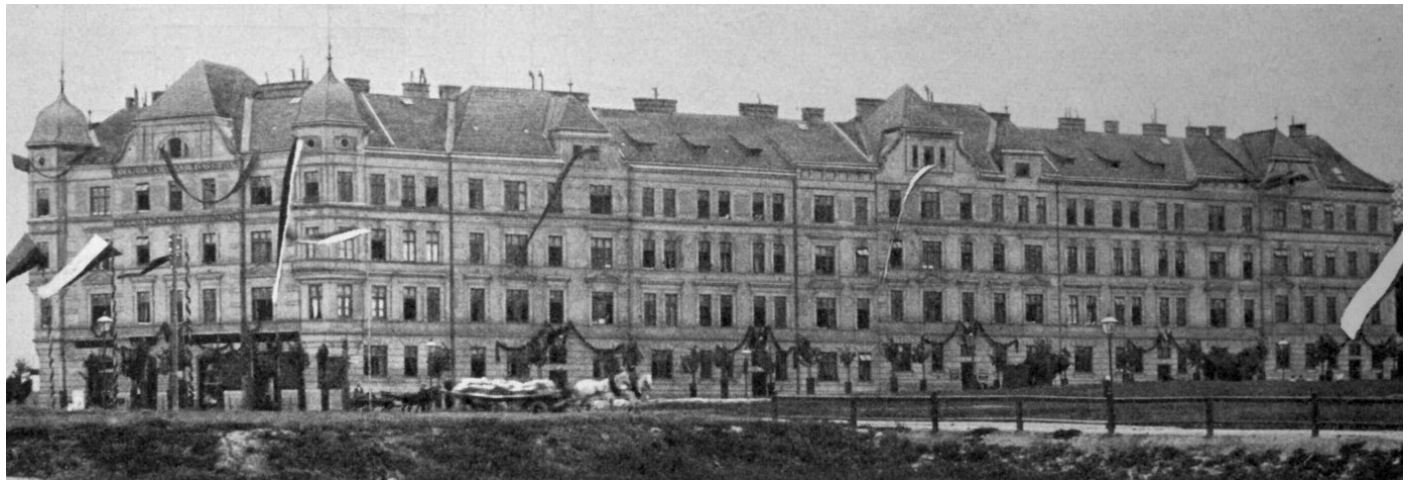
Abb. 4: Kaiser-Franz-Josef-Jubiläumsstiftung (Lobmeyrhof), erbaut zwischen 1897 und 1908, teilweise abgerissen
