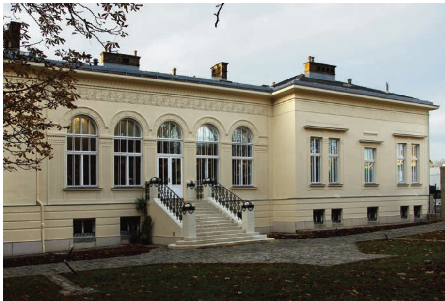
Abb. 53: Das Offizierskasino der ehemaligen Kaiser-Franz-Josephs-Kaserne in der Maroltingergasse 2, seit 2009 das Baha'i-Center Austria
