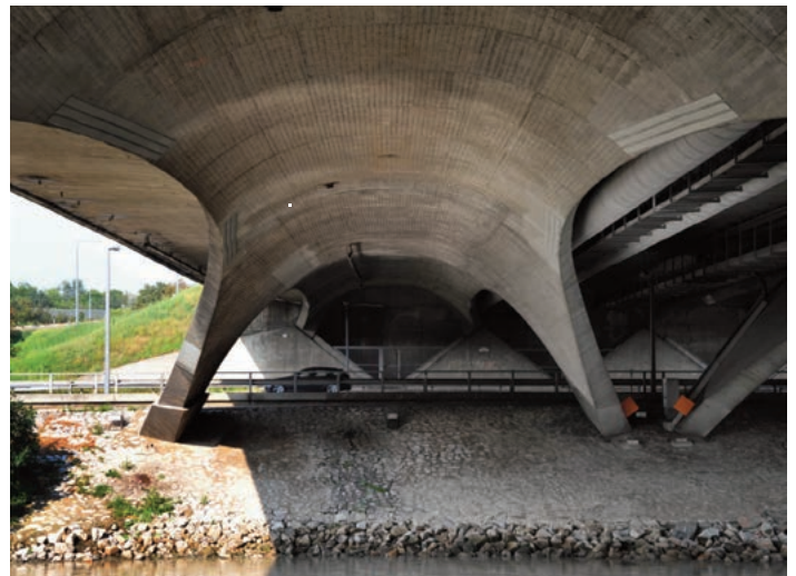
Abb. 66: Die Erdberger Brücke von Arch. Alfred Pauser
